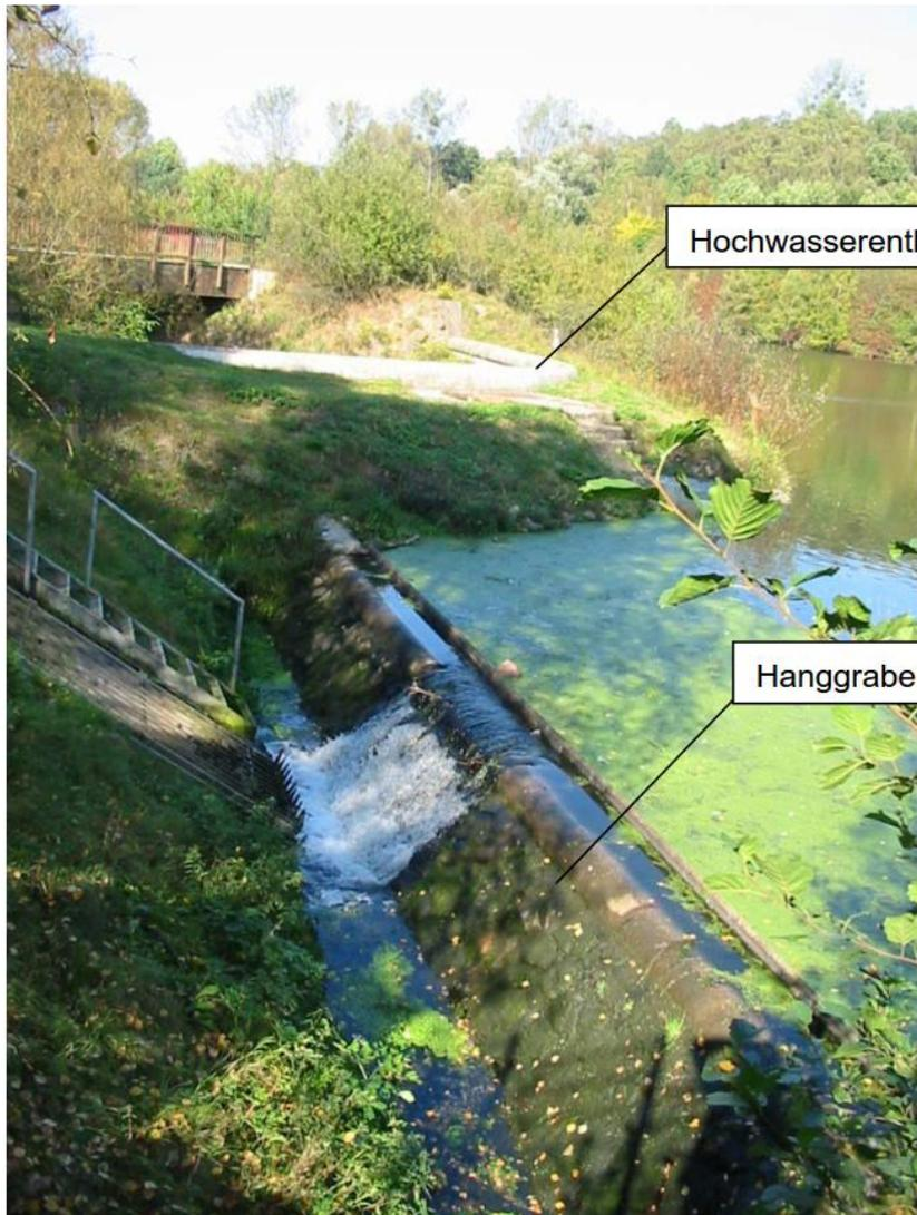
Abbildung 15: Hanggraben und Hochwasserentlastung des HRB
