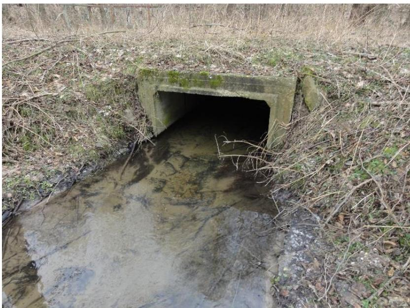
Abbildung 10: Kastenprofil im Zulauf des südlichen Vorbeckens
