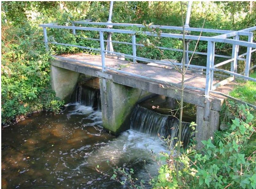
Abbildung 12: Klappenwehre im Zulauf des nördlichen Vorbeckens
