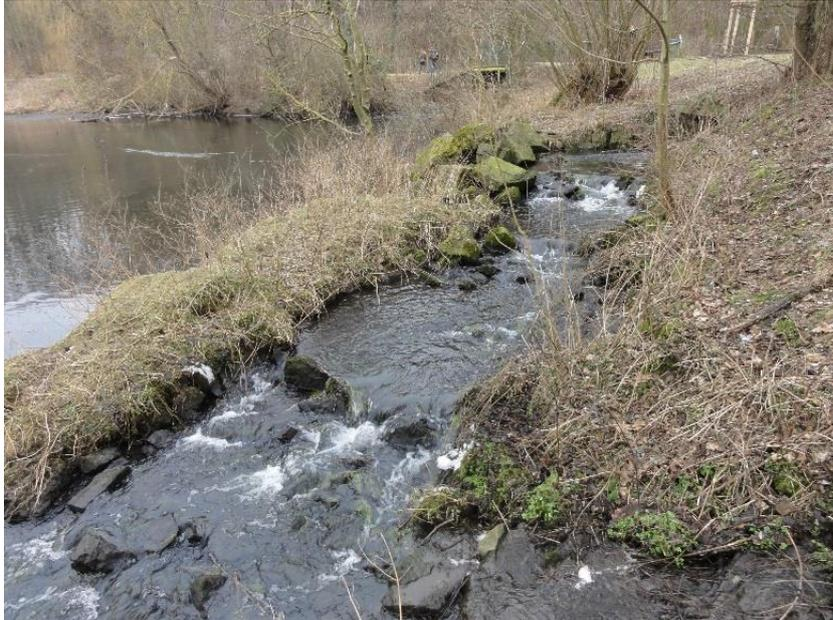
Abbildung 11: Raue Rampe zwischen südlichem Vorbecken und Hauptbecken
