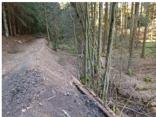
Abb. 20 Wegebaumaßnahme im Bereich der Fläche.
