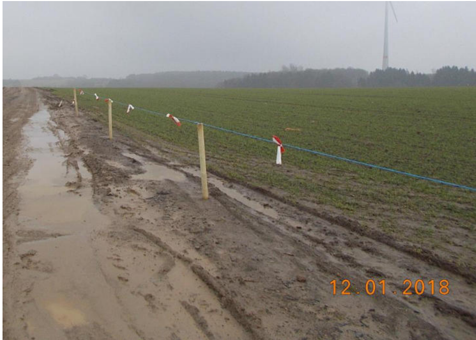
Abb. 44: Beispiel einer Baufeldbegrenzung mittels Pfosten, Spanschnur und Flatterband
