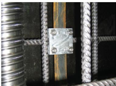
Abb. 9: Verbindung Blitzschutzseisen mit Bewehrung
