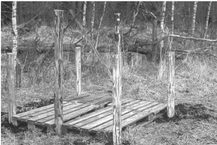
Die sechs Pfähle sind gesetzt, die Paletten auf den Erdboden gelegt
