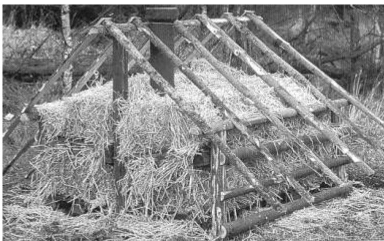
Die Dachspannen sind aufgenagelt. Links gehen sie bis zum Boden.
