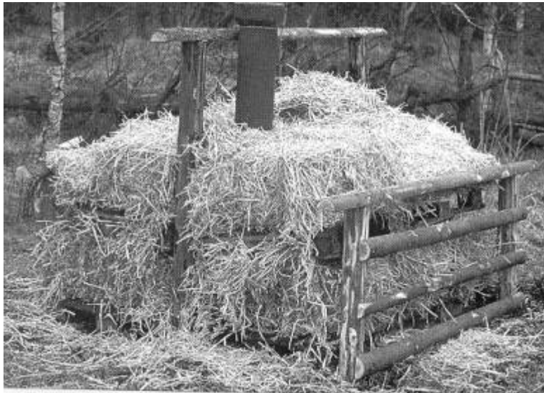
Die zweite Palettenschicht ist eingebracht, das Rohr aufgestellt
