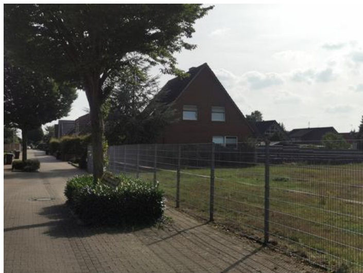
Abbildung 8.17: Nord-Ostansicht SR-19 (Kämpensiedlung 1a; 48619 Heek)
