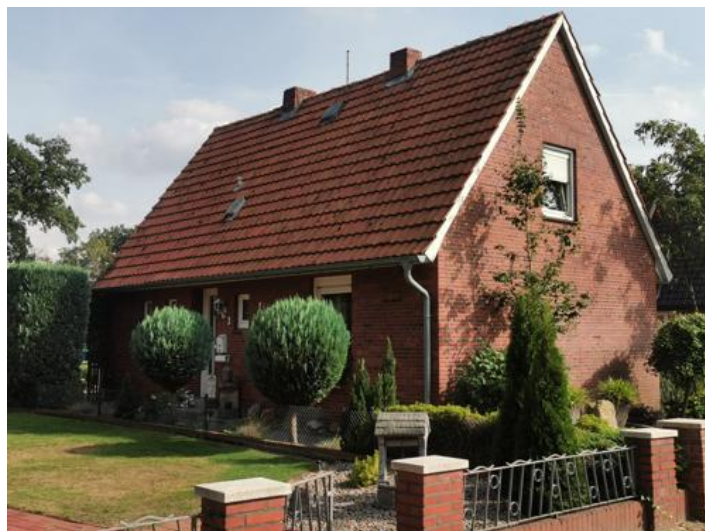
Abbildung 8.15: Nord-Westansicht SR-17 (Kämpensiedlung 3; 48619 Heek)
