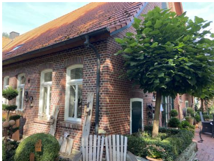
Abbildung 8.27: Süd-Ostansicht SR-30 (Ahle 71; 48619 Heek)
