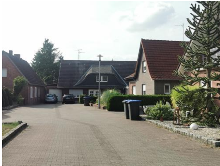
Abbildung 9.14: Ostansicht IO-14 (Kämpensiedlung 24; 48619 Heek)
