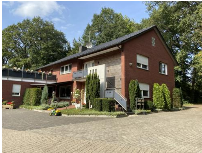
Abbildung 9.4: Süd-Ostansicht IO-04 (Wichumer Straße 7; 48619 Heek)
