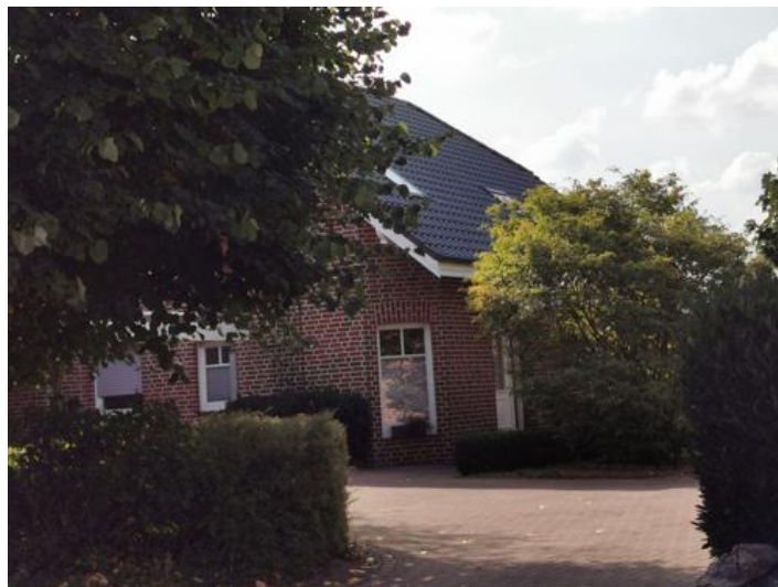
Abbildung 9.7: Nord-Ostansicht IO-07 (Bernhardstraße 19a; 48619 Heek)
