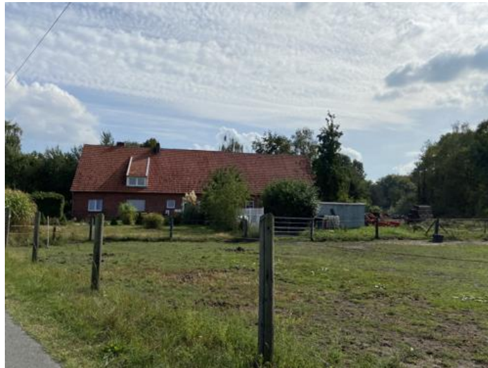
Abbildung 9.2: Nord-Ostansicht IO-02 (Wichumer Straße 5; 48619 Heek)
