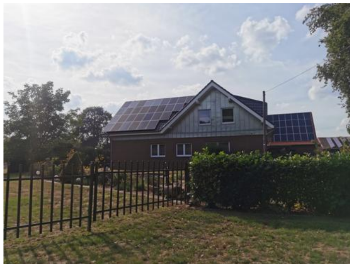
Abbildung 9.13: Ostansicht IO-13 (Venndamm 13; 48619 Heek)
