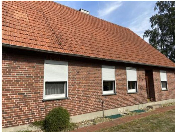
Abbildung 9.12: Süd-Ostansicht IO-12 (Venndamm 21; 48619 Heek)
