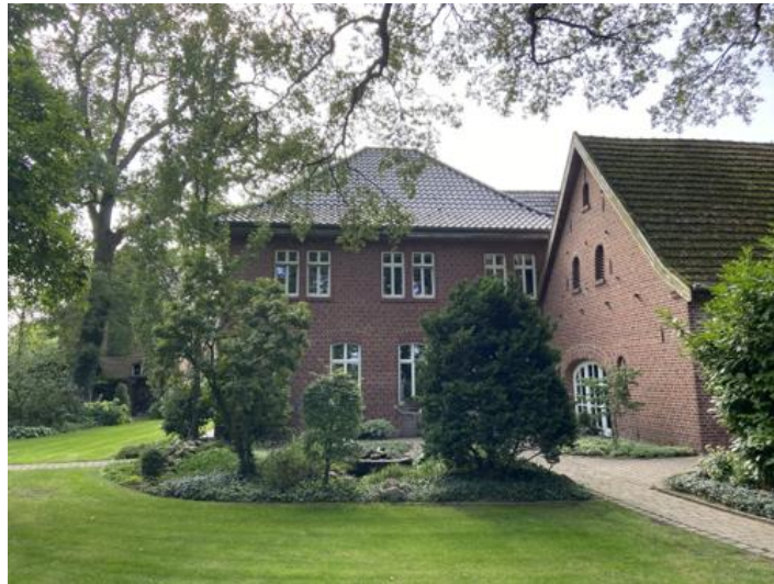
Abbildung 9.6: Nord-Ostansicht IO-06 (Wichumer Straße 8; 48619 Heek)
