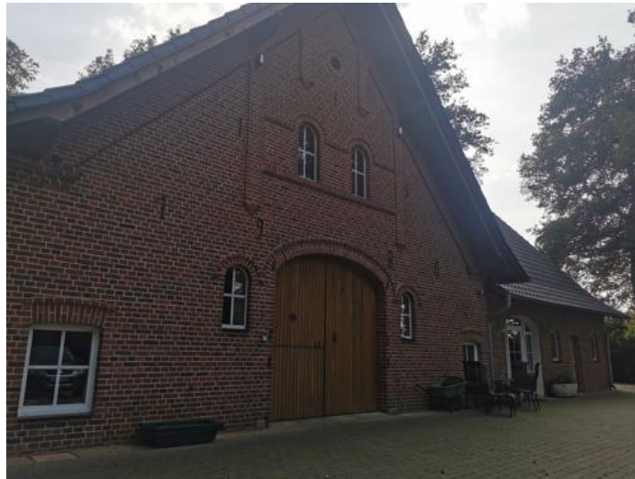
Abbildung 9.10: Nordansicht IO-10 (Venndamm 10; 48619 Heek)
