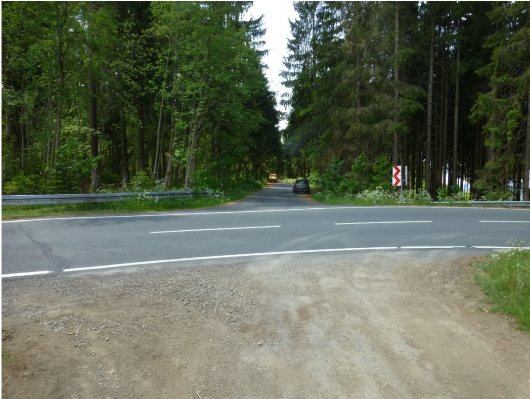
Abbildung 3.9: Einfahrt von der Landesstraße L 729 / L 1571 auf die geplante Zuwegung (Blickrichtung Südwesten)
