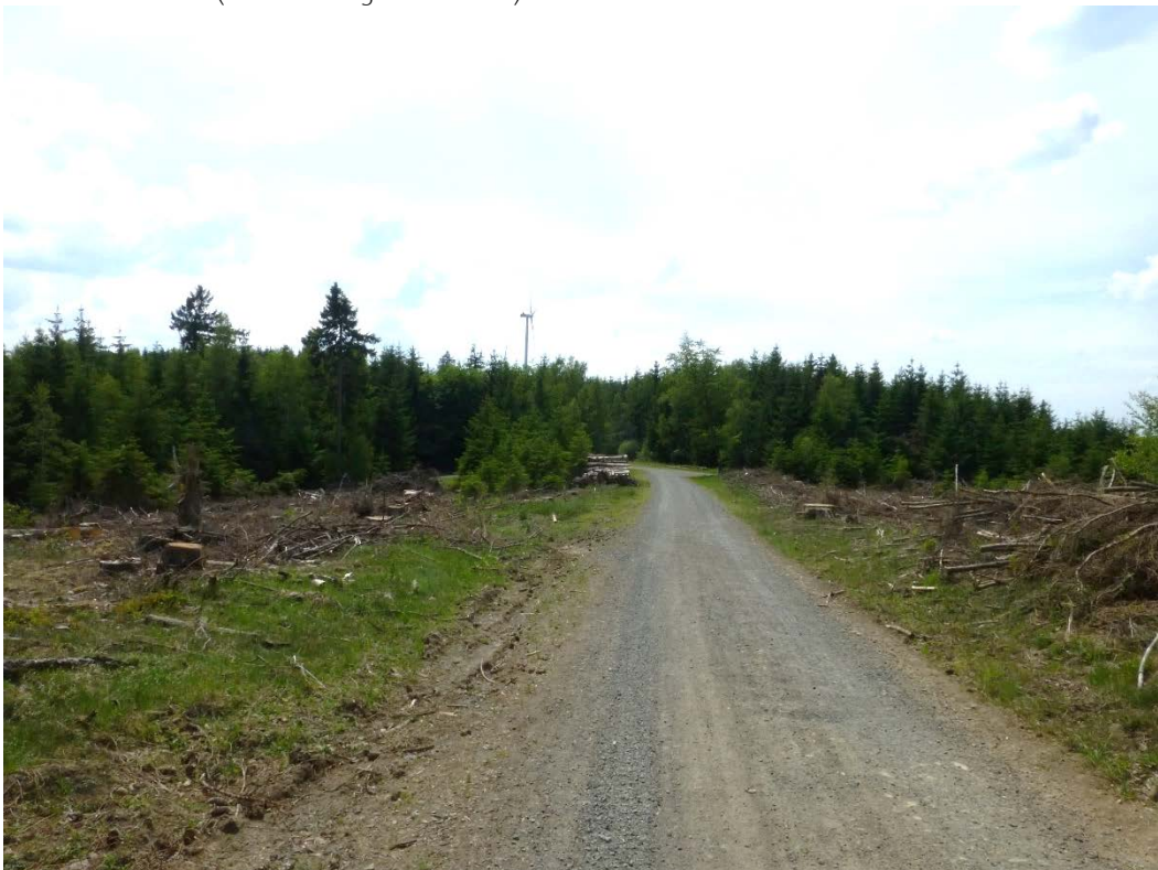
Abbildung 3.12: Zur Verbreiterung vorgesehener Forstweg (Blickrichtung Südwesten)
