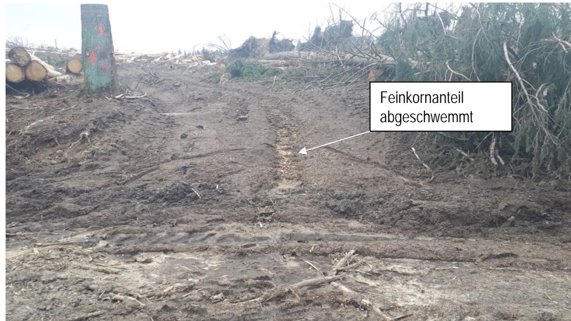
Erosion nach Kahlschlag / Bodenbeanspruchung durch Rodungsarbeiten, Blickrichtung Süden
