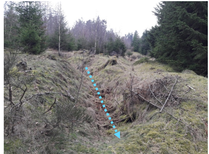
Künstlich angelegte Entwässerungsstruktur/Graben, Entwässerung erfolgt Richtung Norden, kein Durchlass unter der Straße, Blickrichtung Süden
