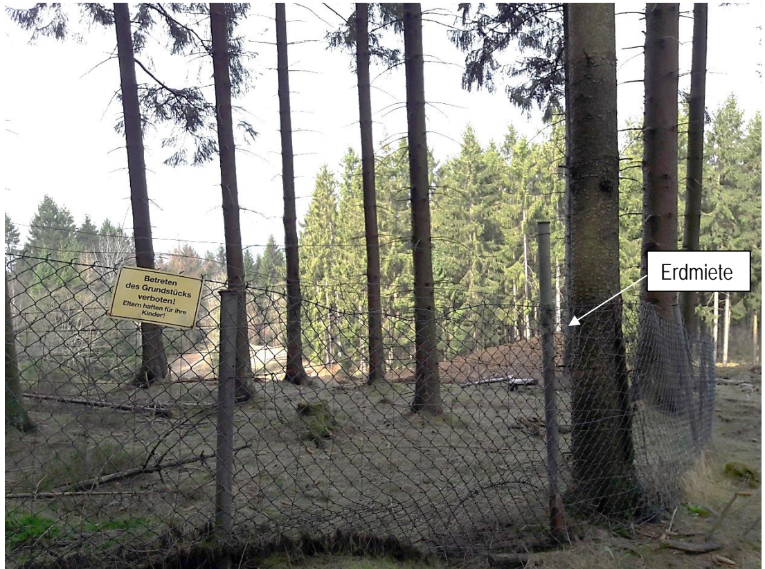
Erdarbeiten am Rand der Zuwegung, Nutzen unklar, Blickrichtung Norden
