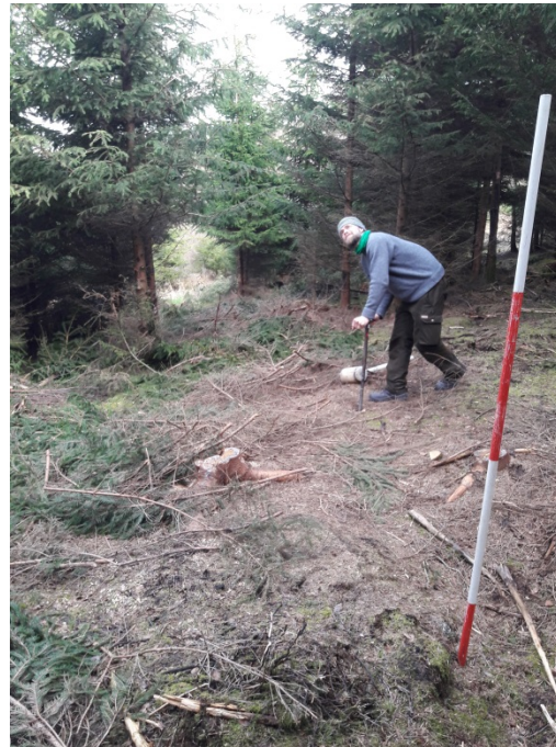
BP2, Rot-Weiße-Stange markiert die geplante Fundamentmitte der WEA03
