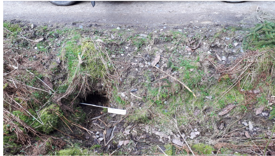
Durchlass unter Zuwegung, DN 400 (Beton), Blickrichtung Nordwesten
