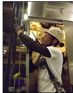
4. Den Sicherheitshaken an der Außenseite des Transportaufzugs lösen und ebenfalls an einem dafür vorgesehenen Anschlagpunkt an der Leiter befestigen.
