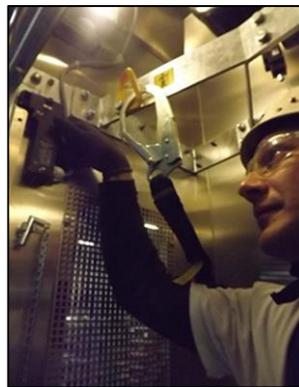
3. Den zweiten Sicherheitshaken an der Sicherungsöse an der Außenseite des Aufzugs befestigen. Anschließend den ersten Sicherheitshaken von der Sicherungsöse in der Kabine lösen und an einem dafür vorgesehenen Anschlagpunkt an der Leiter befestigen.
