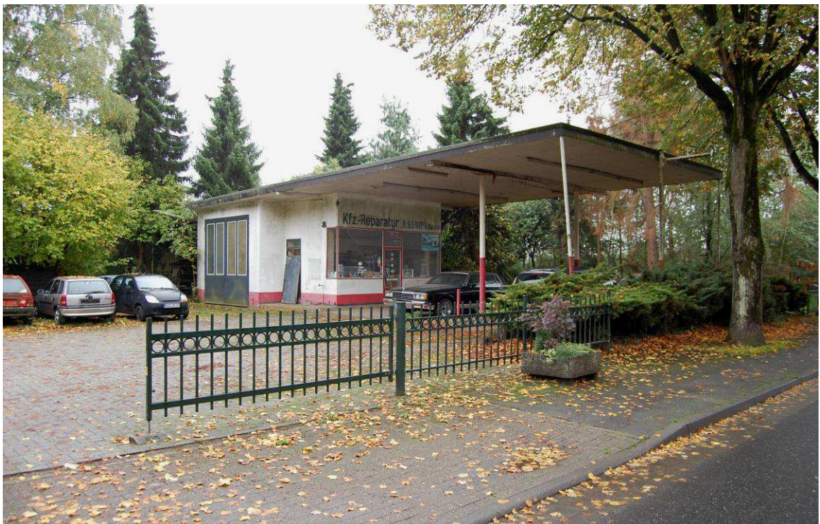
Abbildung 03: Gewerbegebäude 'Bahnhofstraße 71' (ehem. Tankstelle/Kfz-Werkstatt)
