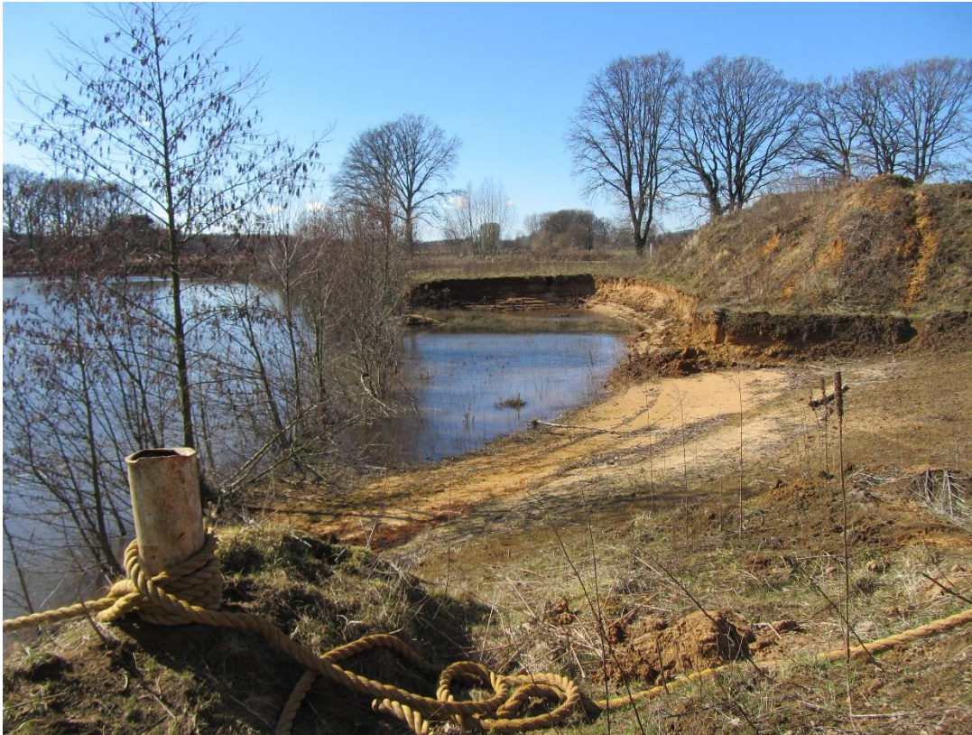
Abbildung 4: Stand der Baumaßnahme Flachwasserzone im Nordwesten, März 2018
