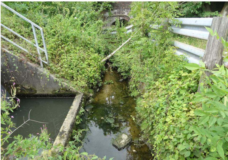
Abb. 9: Bild des Neustädter Bachs auf Höhe der geplanten Leitungsquerung
