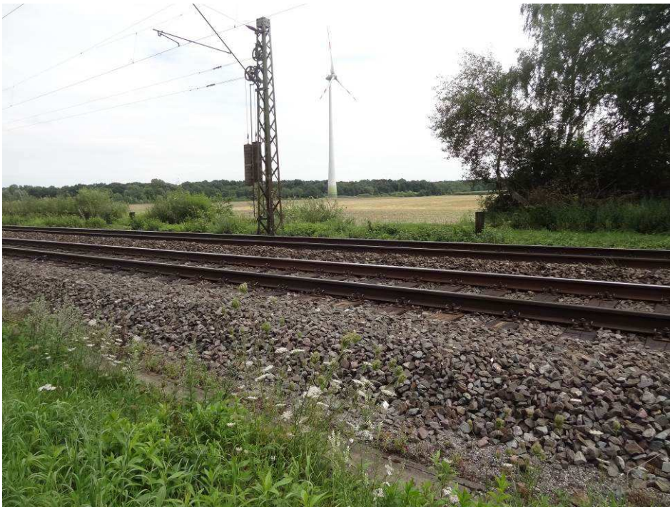
Abb. 1: Querungsbereich der Trasse mit der Bahnlinie Hamm-Lünen zwischen BAB 1 und Industriestraße
