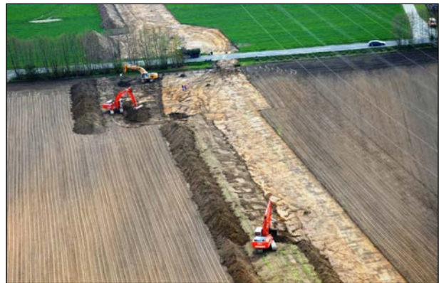
Abbildung 12: Abschieben und Lagern des Oberbodens
