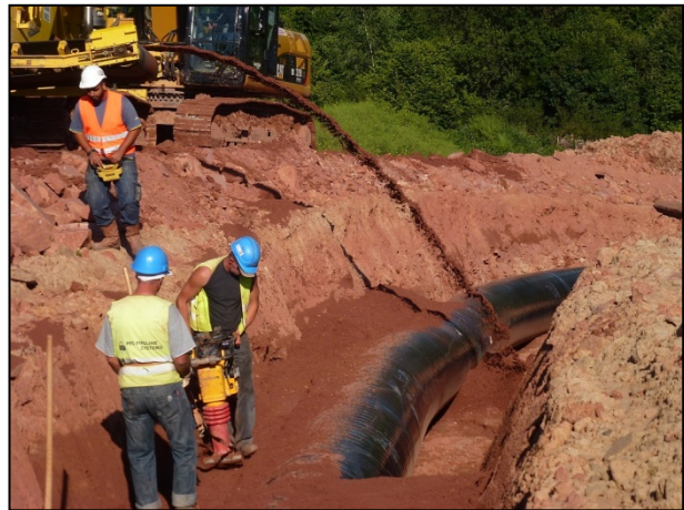
Abbildung 16: Verfüllen des Rohrgrabens (Ltg. im Bild mit DN 1.000)
