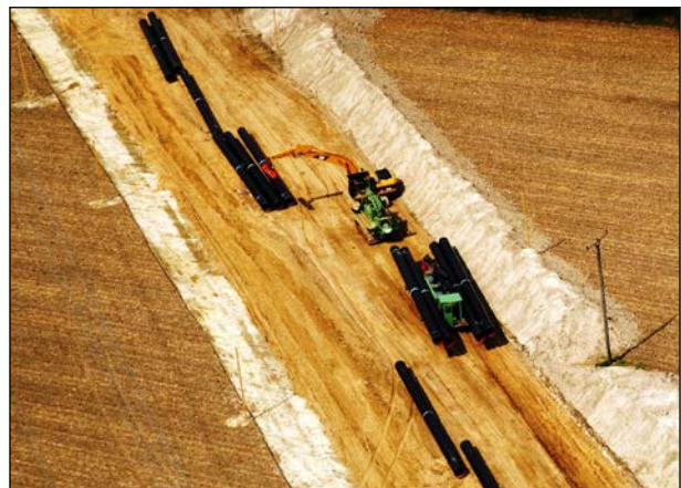
Abbildung 11: Rohrausfuhr im Arbeitsstreifen
