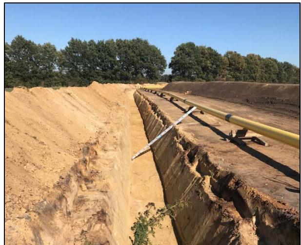
Abbildung 14: Rohrgraben und Leitung in DN 300
