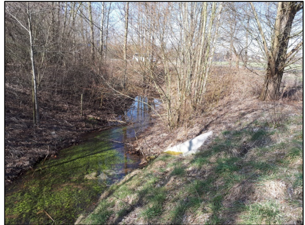
Abbildung 29: Kleine Bever, Ausgleichsmaßnahme Kreis Unna, Einmündungsbauwerk rechts
