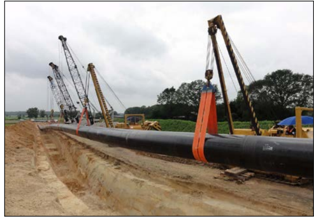
Abbildung 15: Absenken des Rohrstranges (Ltg. im Bild mit DN 1.000)
