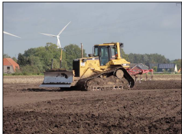
Abbildung 17: Rekultivierung des Arbeitsstreifens
