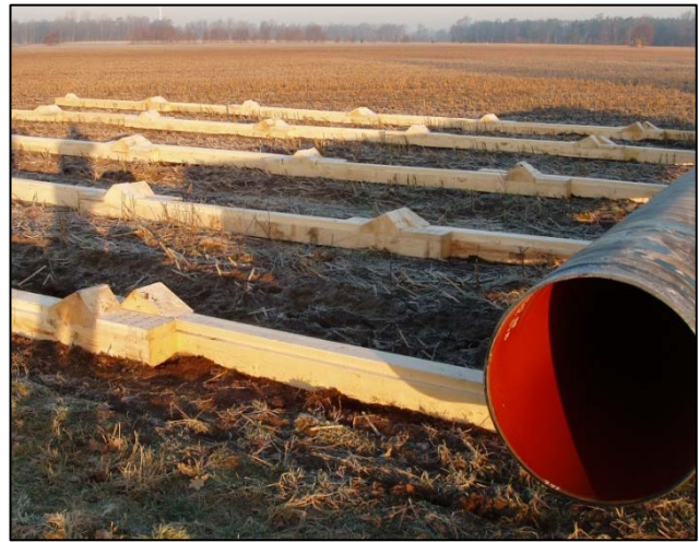
Abbildung 8: Holzbalcken zum Lagern der Rohre (Bsp. DN 1000)
