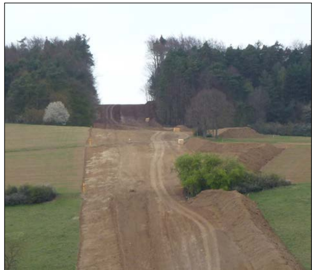
Abbildung 7: Arbeitsstreifen im Wald (Einengung / Aufweitung)
