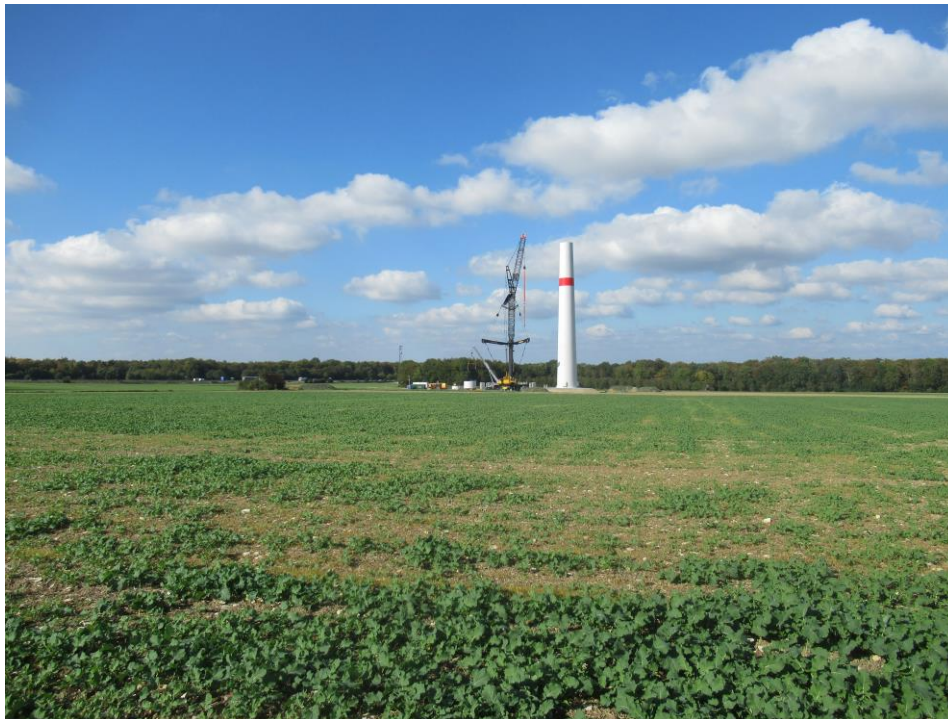
Abb. 20: Errichtung der WEA-Türme im Windpark Etteln-West, Foto: 8.10.21.
