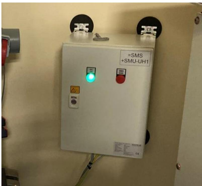
Abbildung 11-1: SMU4 Modul des Schattenwurfschutzsystem
