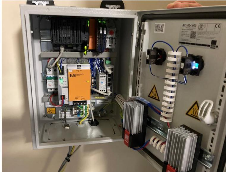
Abbildung 11-2: Innenansicht SMU Modul des Schattenwurfschutzsystem
