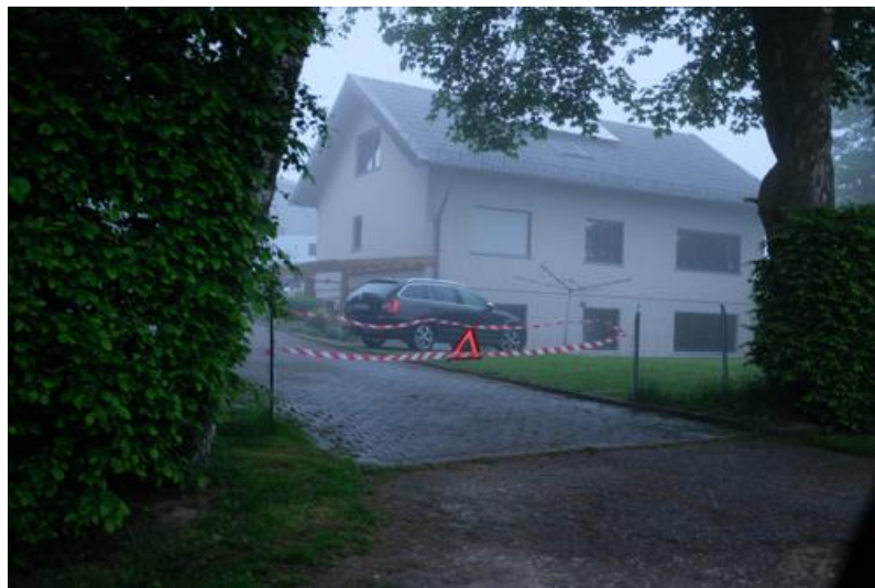
Abbildung 9.9: Südansicht IO-09 (Braunsohle 23; 33100 Paderborn)
