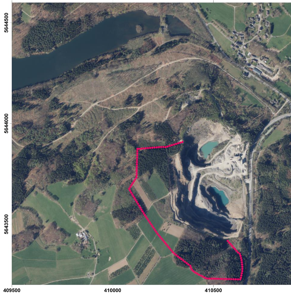
Abbildung 1: Luftbild des Steinbruchs mit geplanter Erweiterungsgrenze (Quelle Kartengrundlage: opengeodata.nrw.de)
