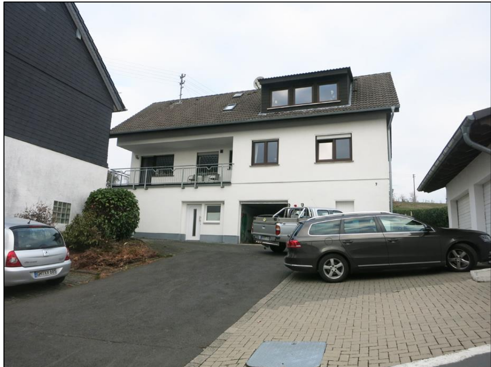
Abb. 15 Wohnhaus Im Unterdorf 7
