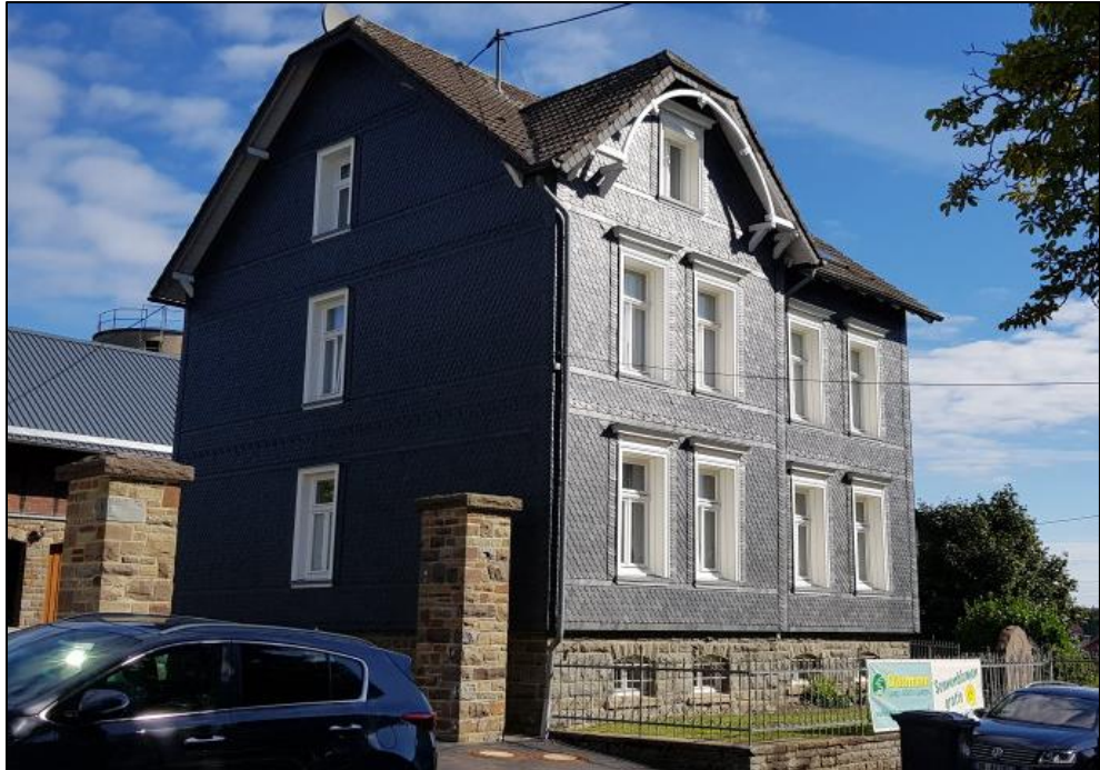
Abb. 19 Wohnhaus Im Oberdorf 5
