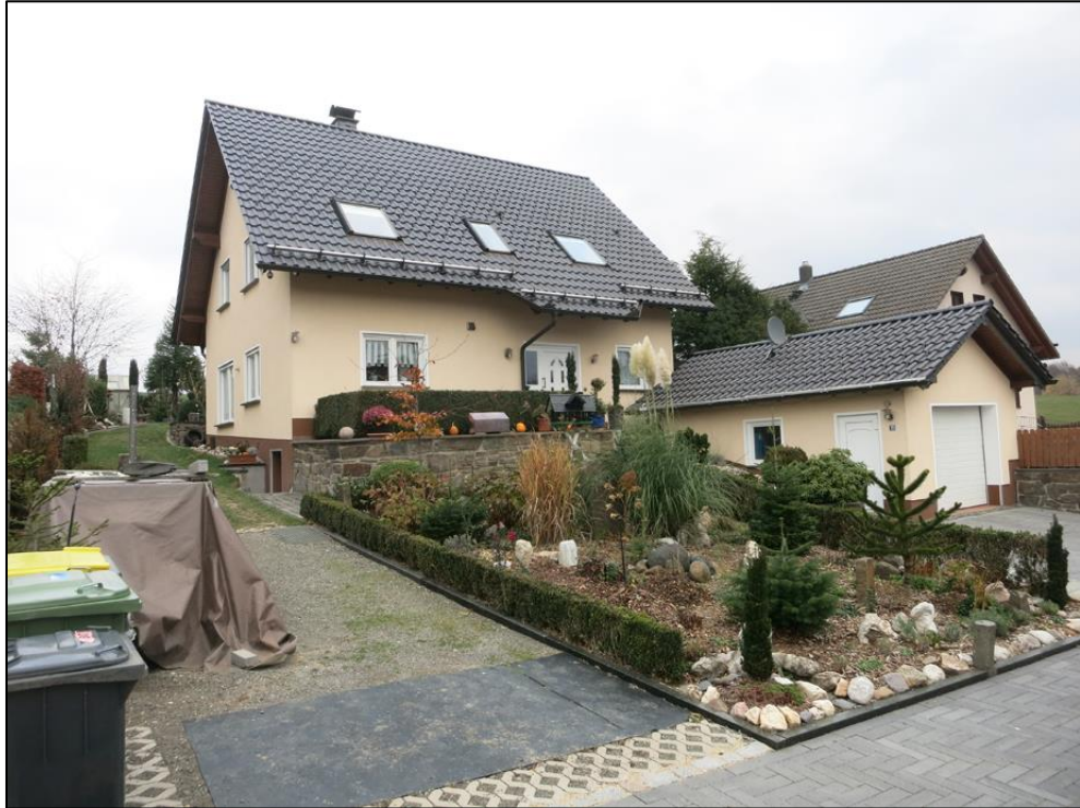
Abb. 11 Wohnhaus Im Unterdorf 19
