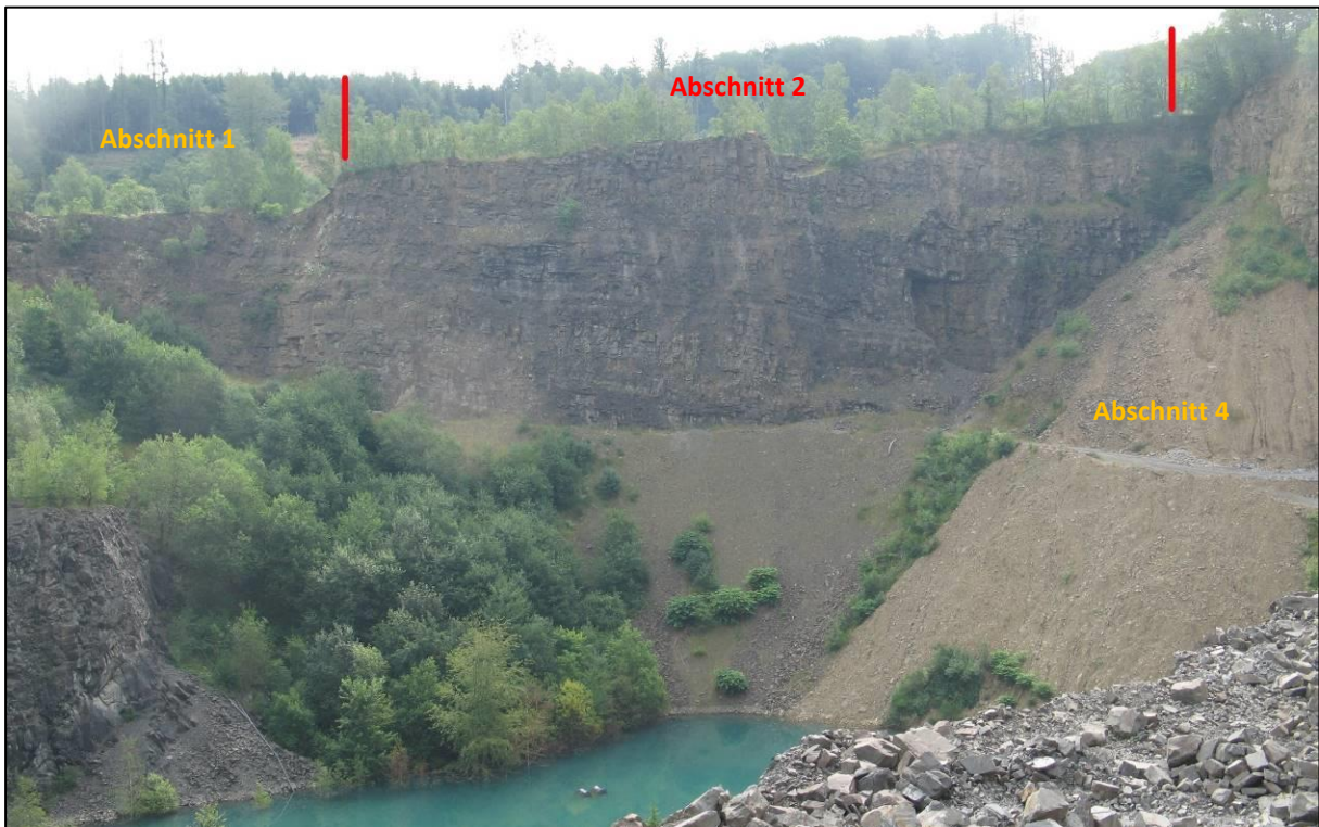
Abbildung 20: Ostwand mit den Homogenbereichen 1 und 2.
