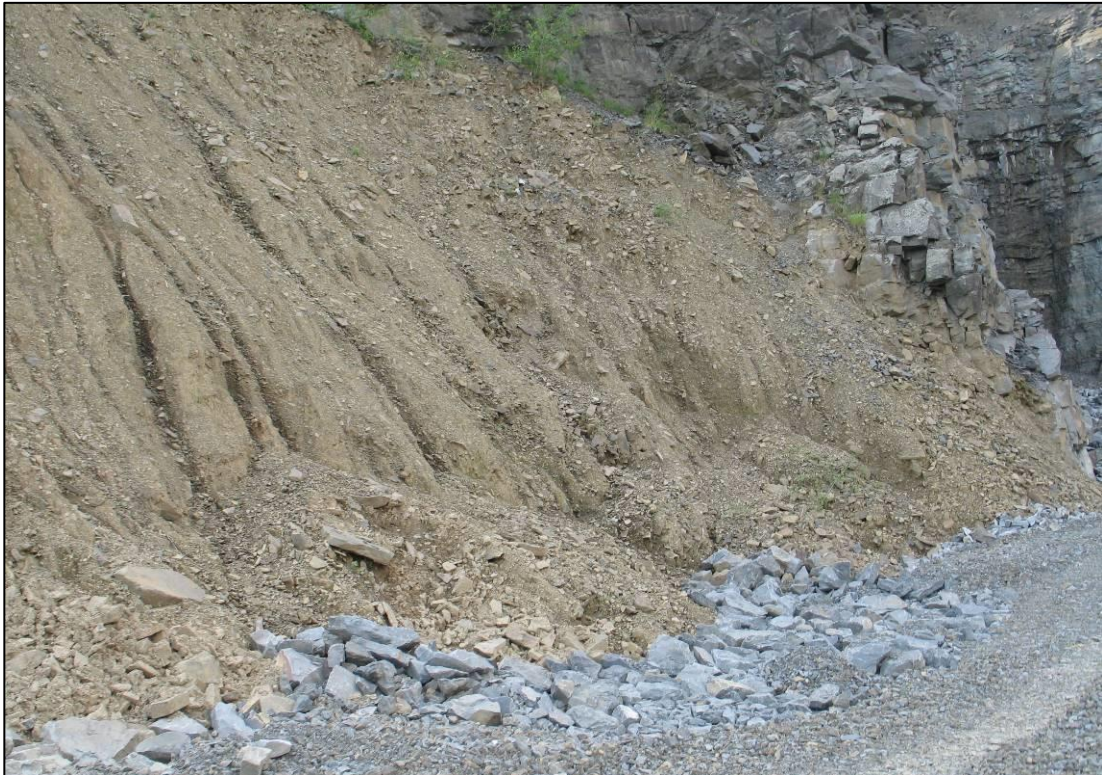
Abbildung 26: Böschungsfuß der temporären Vorschüttung auf der Steinbruchzufahrt im Abschnitt 4.
