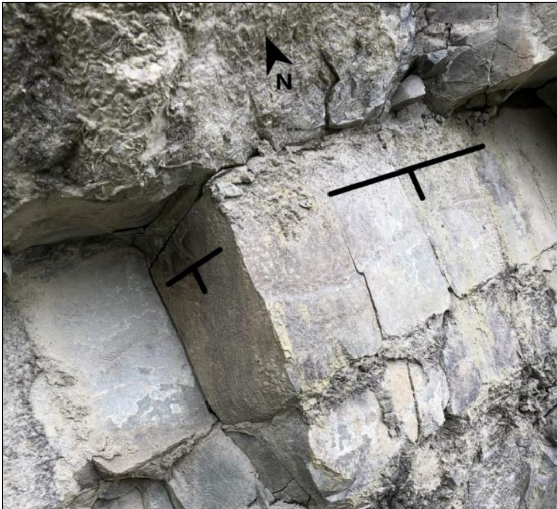
Abbildung 12: Foto der S-einfallenden Klüfte (rechts) und senkrecht dazu orientierten W-einfallenden Klüfte (links) auf der Sohle 283 m NHN.
