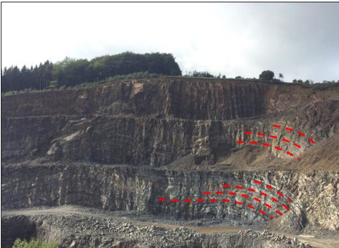
Abbildung 5: Blick auf die südwestliche Abbaufont
