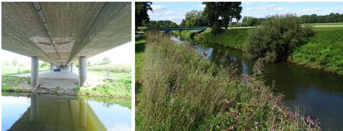
Abbildung 21: Massiv gesicherte Böschungen unterhalb der André-Marie-Brücke (links) und Profilböschungen mit deutlicher Neophyten-Belastung (rechts)
