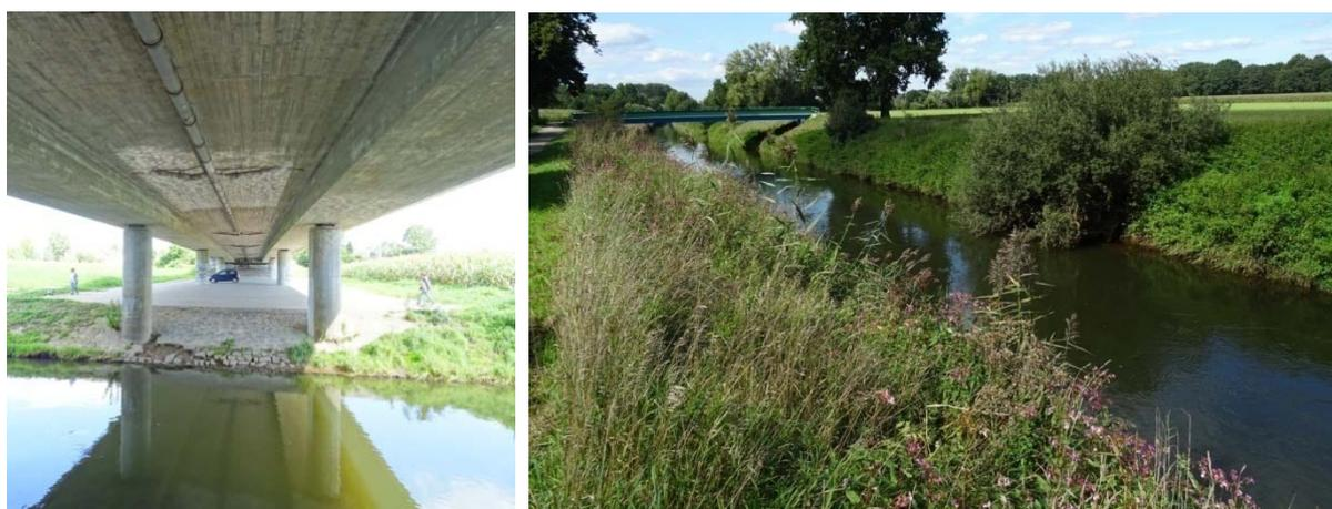
Abbildung 18: Massiv gesicherte Böschungen unterhalb der André-Marie-Brücke (links) und Profilböschungen mit deutlicher Neophyten-Belastung (rechts)
