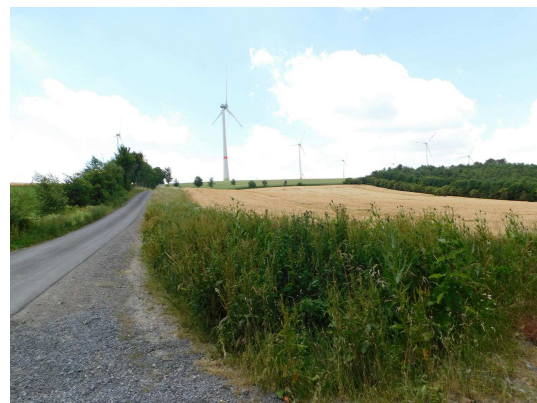
Abb. 10 Blick auf einen zu überbauenden straßenbegleitenden Saum im Zufahrtbereich im WP Fündling (Nord).
