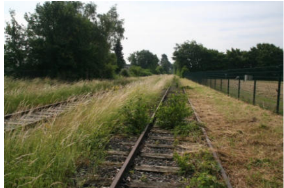
Abb. 11: Westliches Gleis im Bereich der Wasserschutzzone
