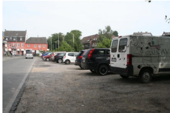
Abb. 17: die alte Ladestraße (Schotterplatz) wird rückgebaut
