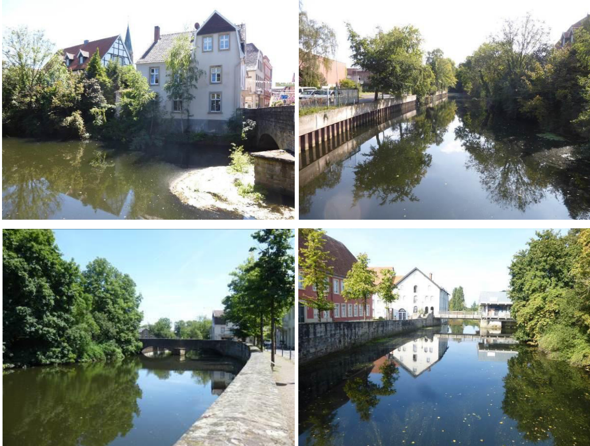
Abb.9: Der Abschnitt „Ems Ost 1“ befindet sich inmitten des innerstädtischen Siedlungsbereichs von Warendorf.
