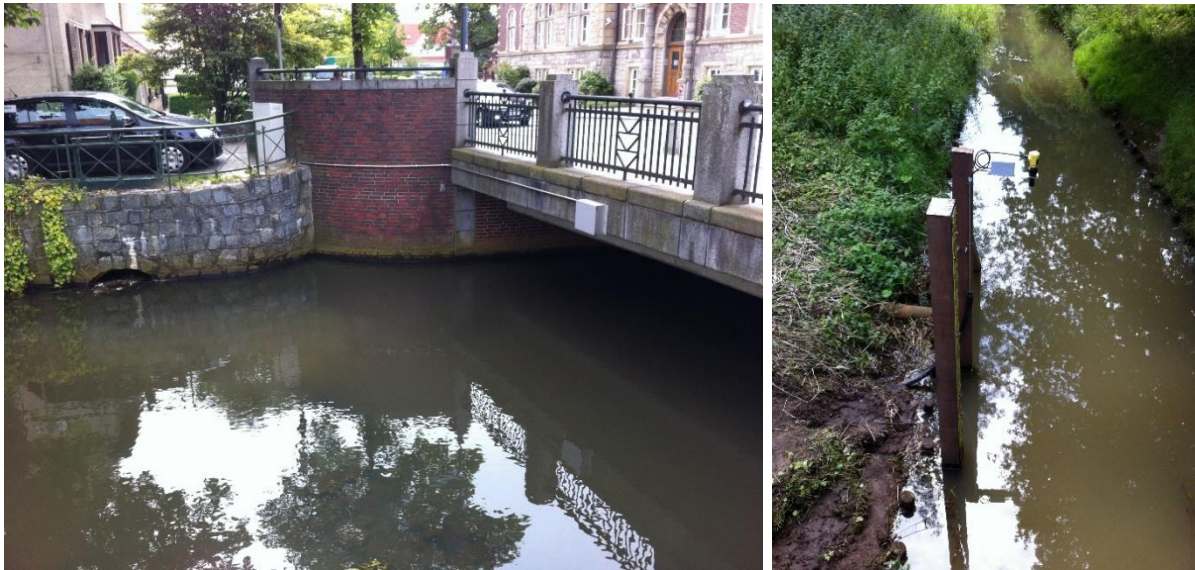
Abbildung 3: Beispiele für die Montage einer Ultraschallpegelmessung links: an Brücke, rechts: an Pegellatte © jbi 2012 beim Ochtumverband, Harpstedt
