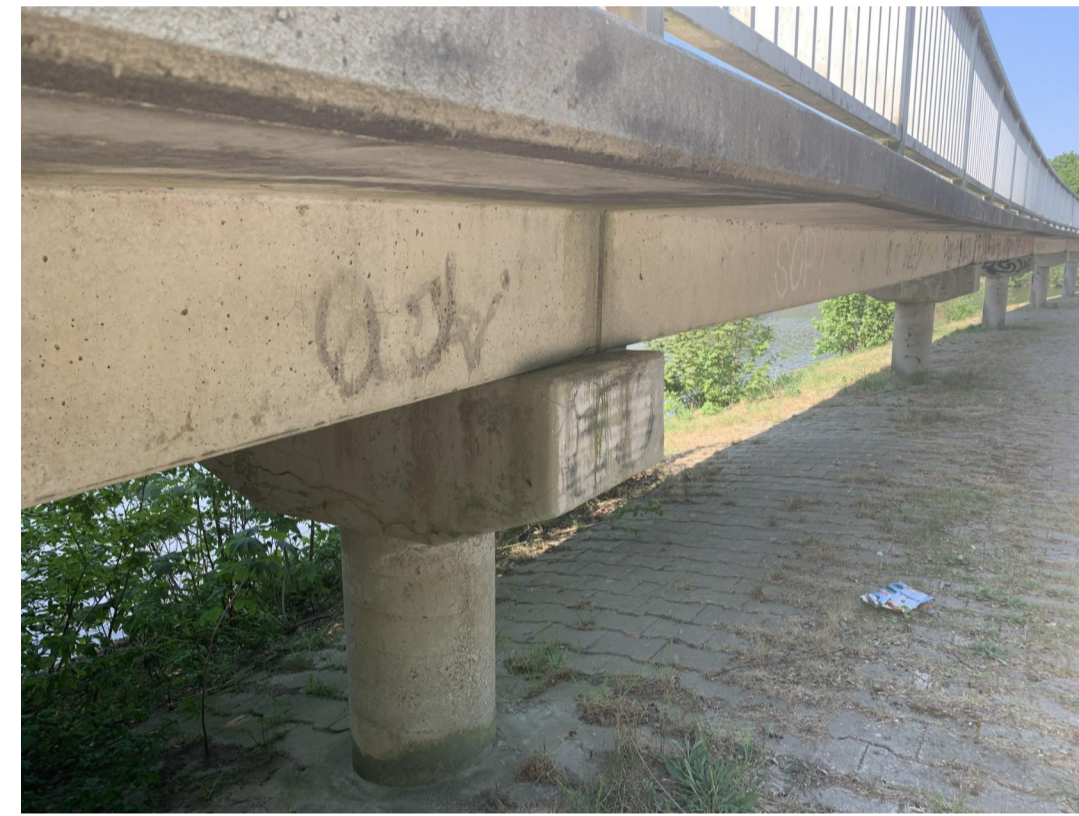
Detail Fußgängerbrücke mit Pfeiler
