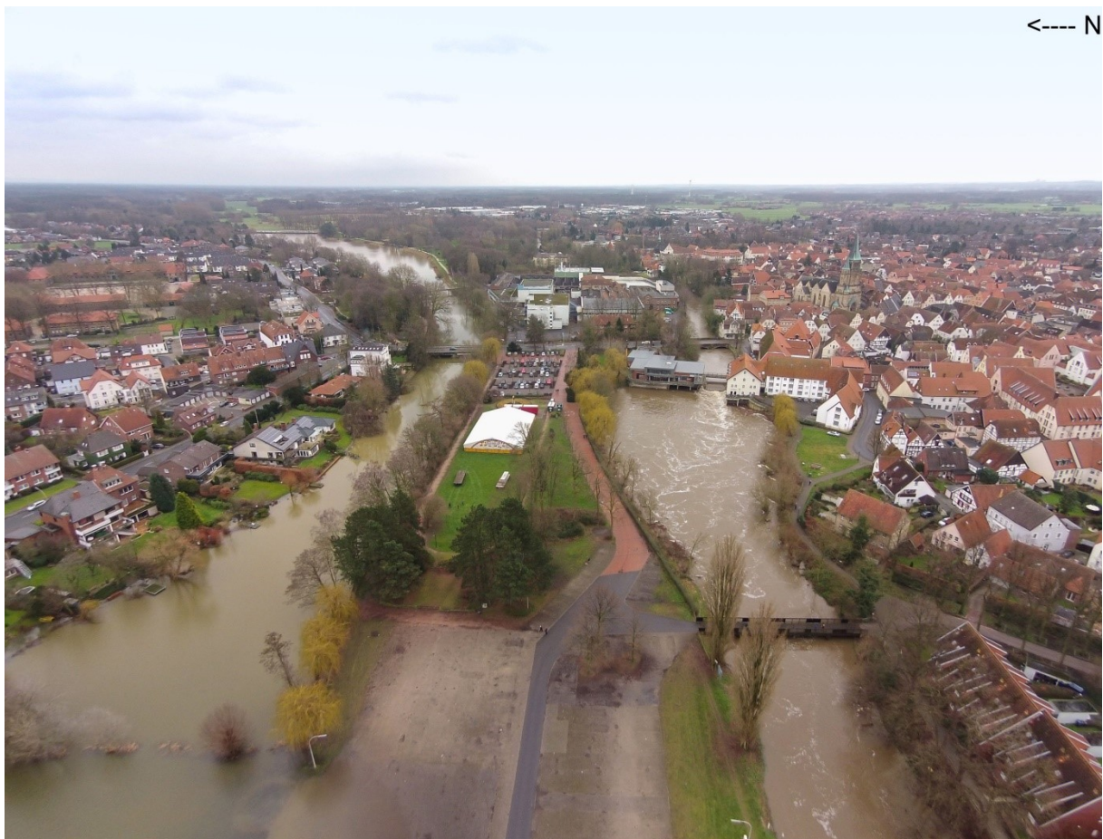
Abbildung 9: Hochwasser vom 31.01.2016. Blick von der Linnenwiese nach Osten Bildautor: André Bauer
