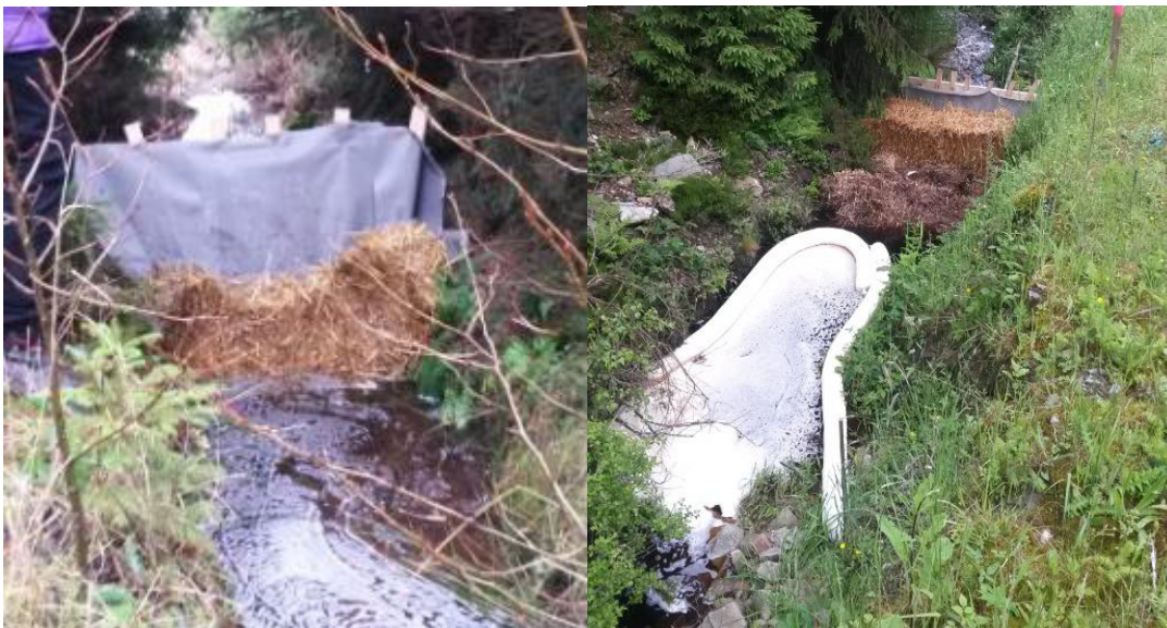
Abbildung 3: Sedimentsperre und Strömungsbarriere zum Rückhalten von absetzbaren Stoffen und zum vorsorglichen Einbau von Sorb-Schlängeln
