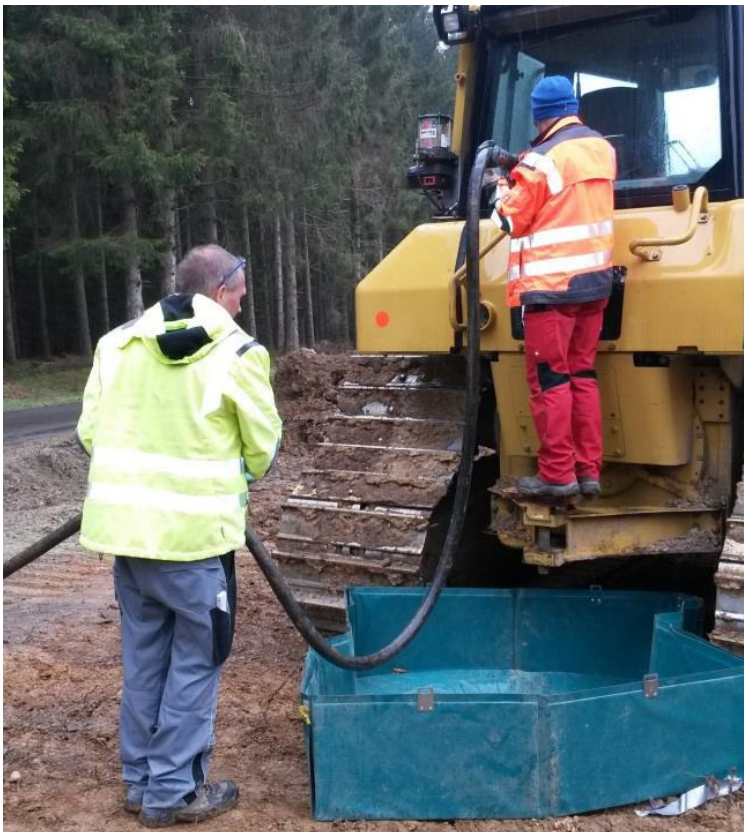
Abbildung 5: Empfohlene Maßnahme: Betankung der Baumaschinen im Baufeld von 2 Personen mit faltbarer Auffangwanne
