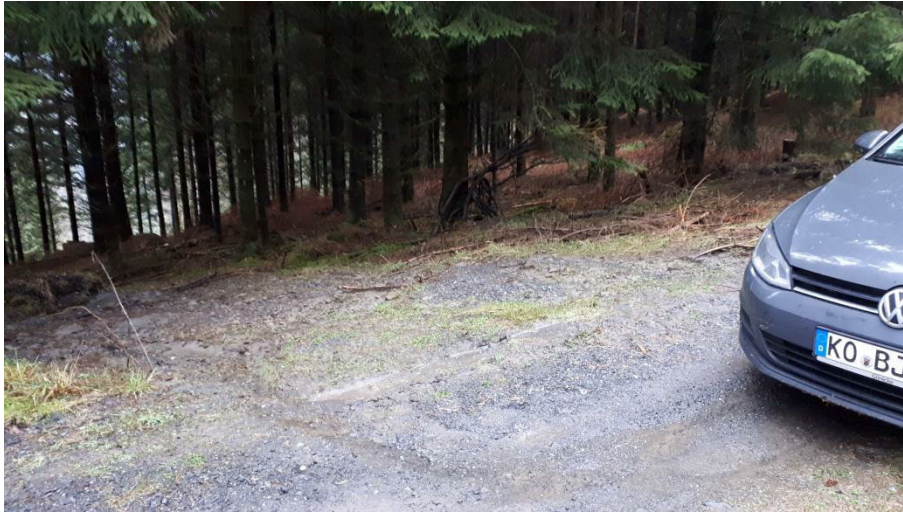
Geschobene Quermulde, Fließrichtung in das geplanten WSG Serkenrode
