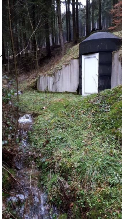
Wasserfassung, Blick Norden
