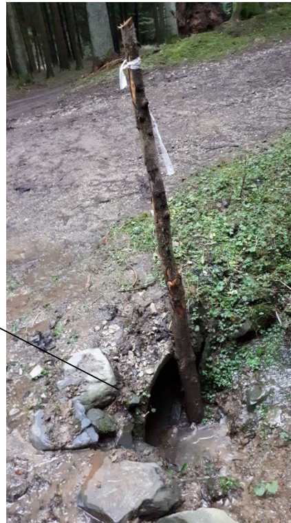
Durchlass in der Wegkehre für den Abfluss aus dem Weggrabensystem, Blick Südosten
