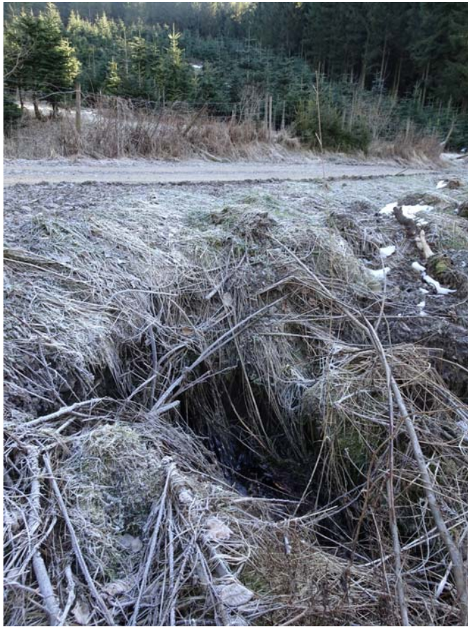
Abbildung 3.2: Durchlass des Quellbachs unterhalb des Bestandsweges
