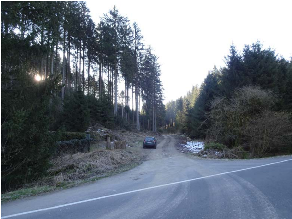
Abbildung 3.10: Einfahrt von der Kreisstraße K 29 auf die geplante Zuwegung (Blickrichtung Süden)
