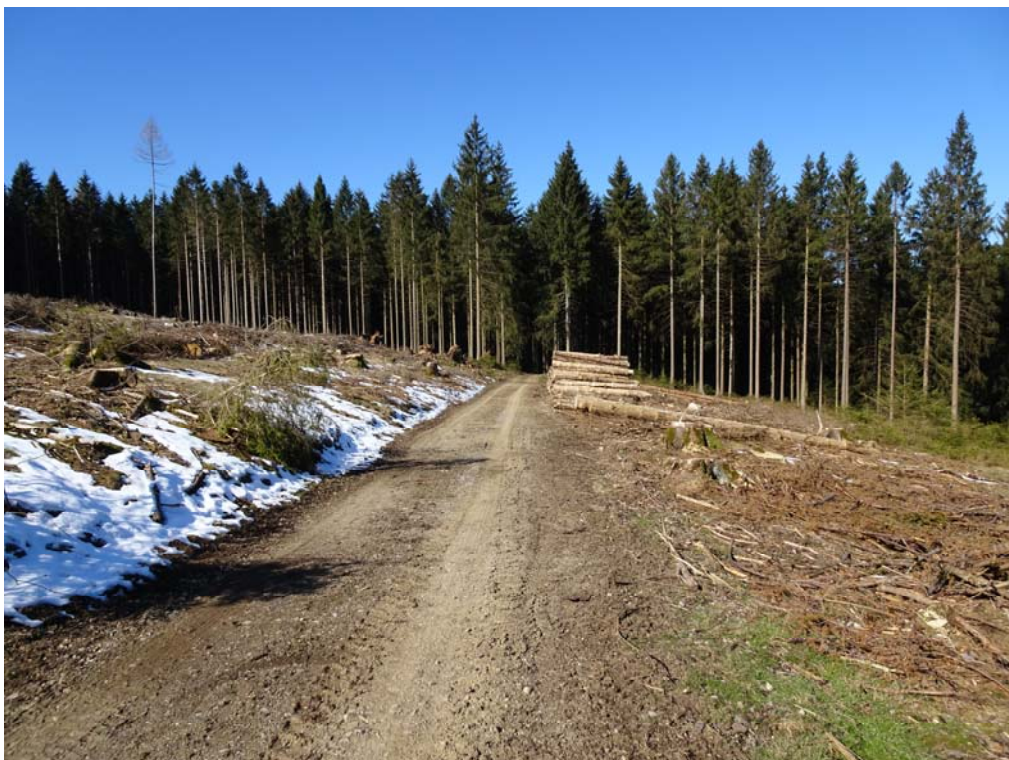
Abbildung 3.12: Zum Ausbau vorgesehener Forstweg zur Erschließung des geplanten WEA-Standorts 1 (Blickrichtung Nordwesten)
