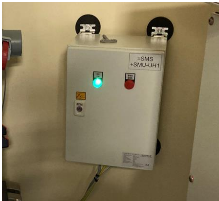
Abbildung 11-1: SMU4 Modul des Schattenwurfschutzsystem
