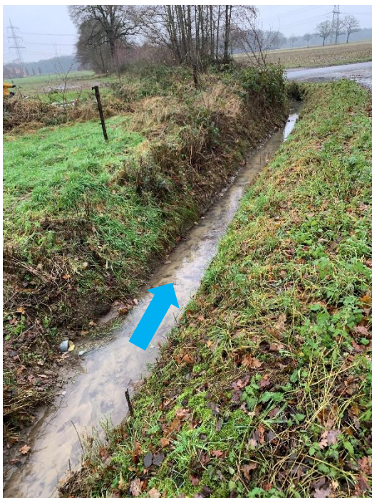
Abbildung 4: Blick Richtung Südwesten auf Höhe der gepl. Gewässerüberfahrt am Gew. 2032
