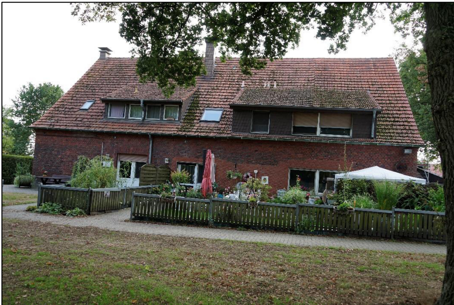
Abb. 8 Wohnhaus Rhader Straße 36 (Nordost-Seite).
