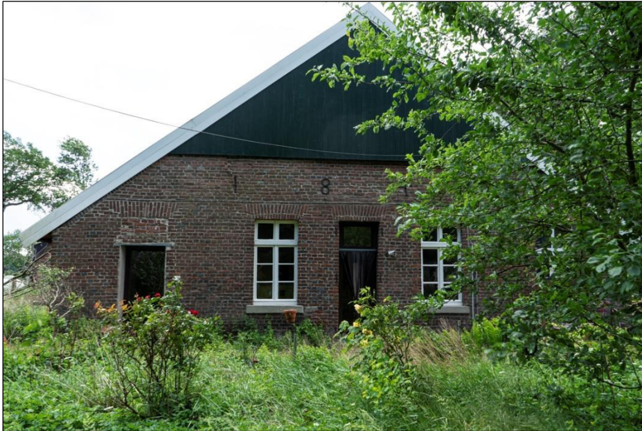
Abb. 20 Nord-Seite des Wohnhauses (betroffene Hausseite)
