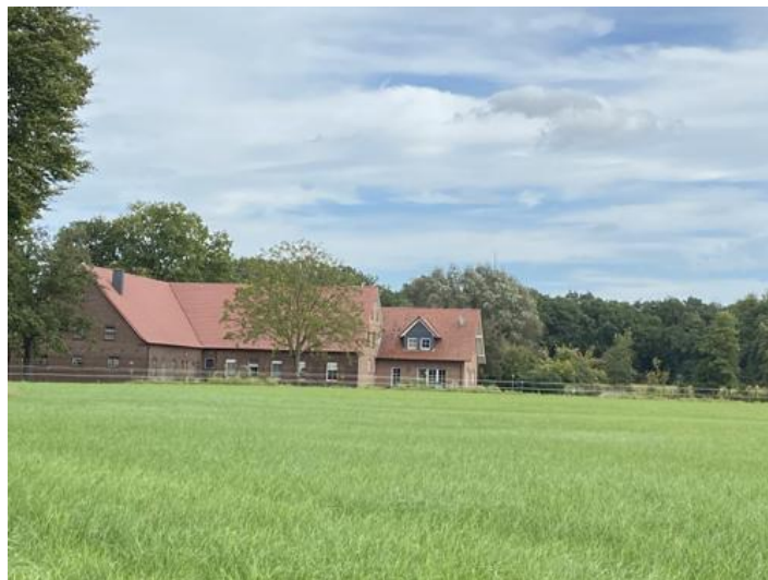
Abbildung 8.13: Südansicht SR-13 (Überwasser 24; 48346 Ostbevern)
