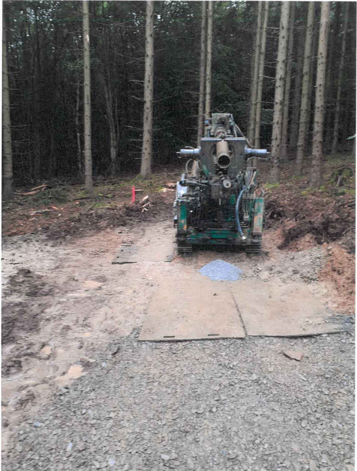
Bild 1 Übersichtsaufnahme Standort WEA 3 mit Raupen-Bohrgerät nach Baufeldfreimachung und mit hergestellter Zufahrt für die Bohrarbeiten
