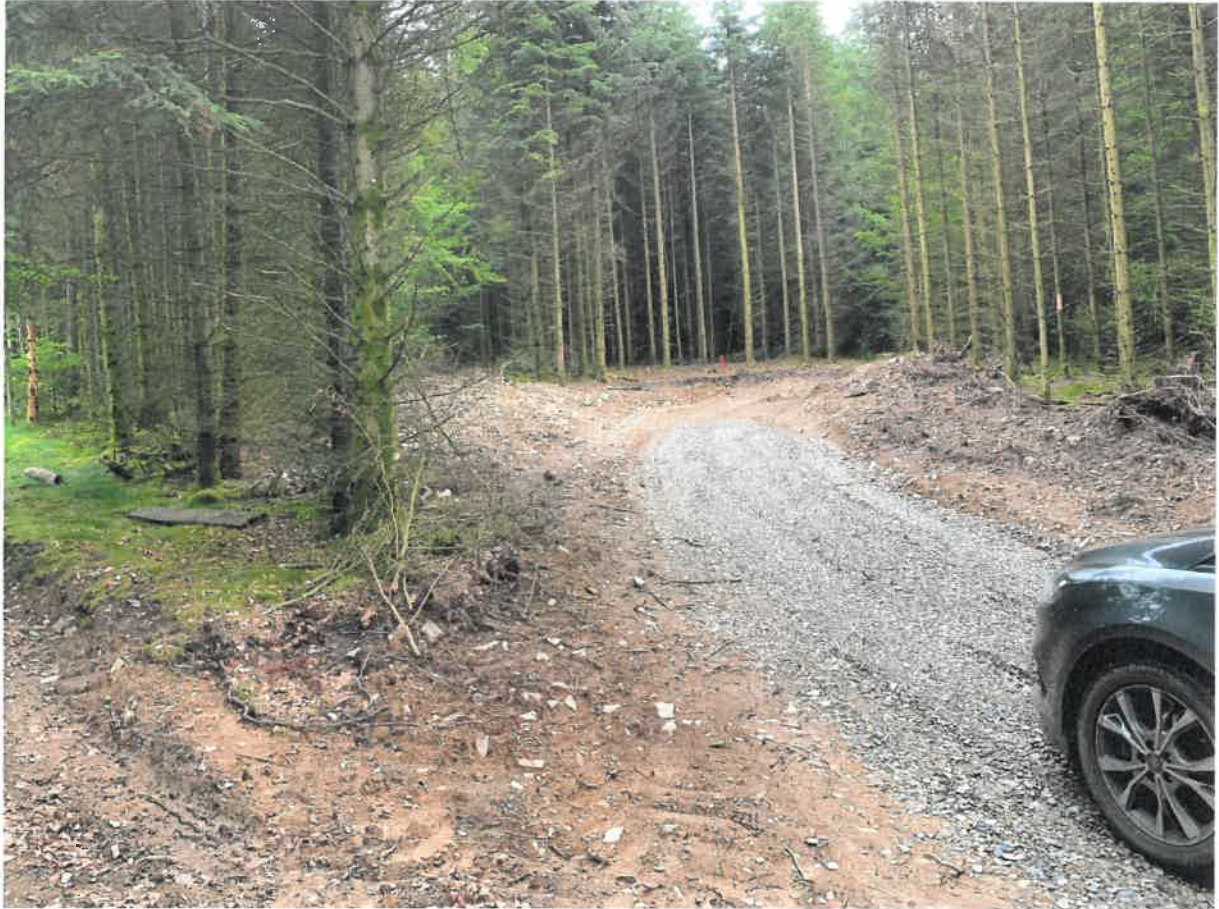
Bild 1 Übersichtsaufnahme Standort WEA 2 (vom Waldweg aus aufgenommen) nach Baufeldfreimachung und mit hergestellter Zufahrt für die Bohrarbeiten
