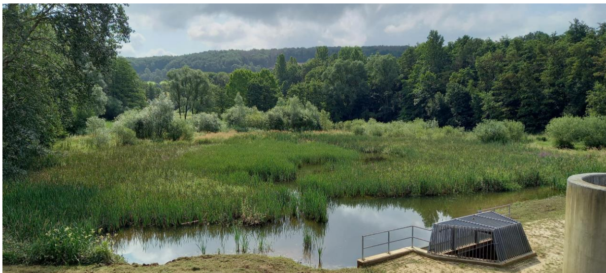
Abbildung 5: Zustand des HRB im Sommer 2021.
