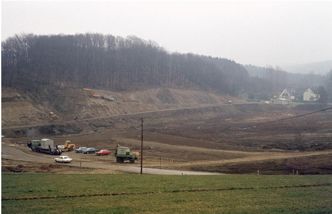
Abbildung 20: Bodenarbeiten während des Baus des HRB 1975 (WV RSK, 1975).
