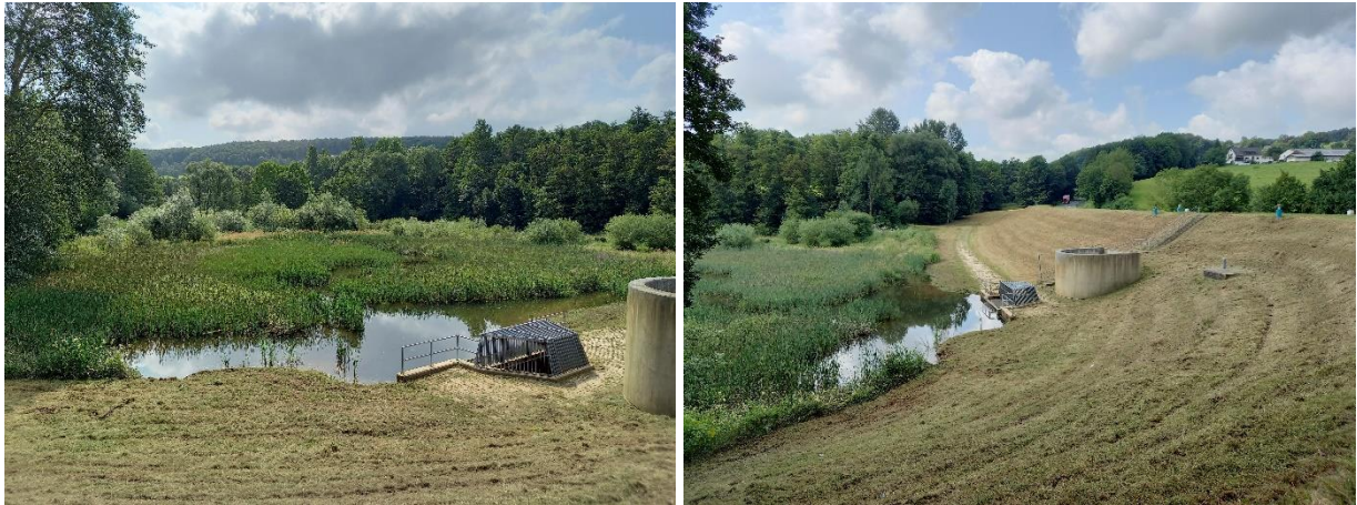
Abbildung 27: HRB mit Röhrichtbestand und Gebüsch (links); Dammbauwerk (rechts).
