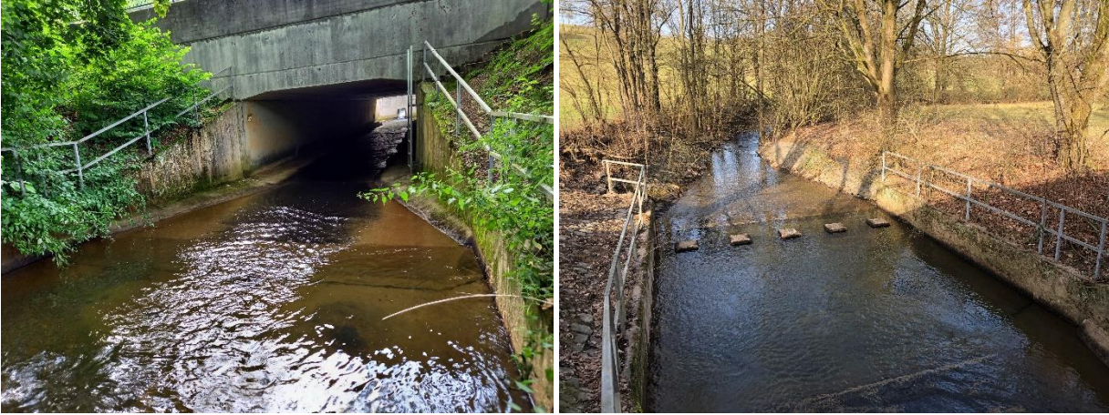
Abbildung 29: Durchlass unter der L 86 (links); Tosbecken westlich der L 86 unterhalb des HRB (rechts).
