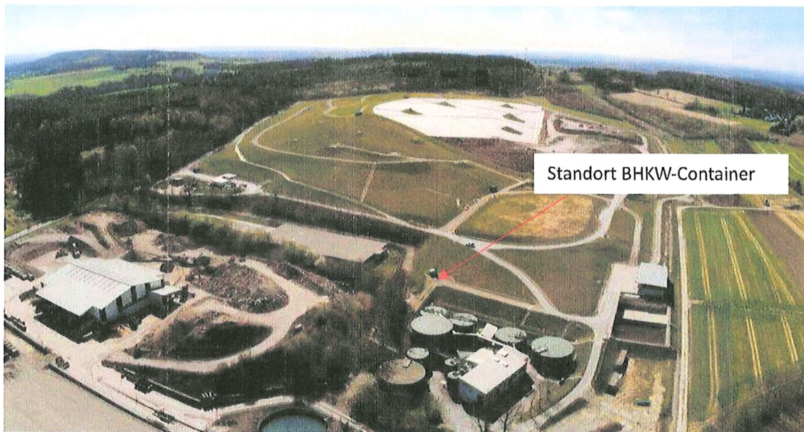
Abbildung 1 - Deponie Reesberg in Kirchlengern (Sickerwasserbehandlungsanlage am unteren Bildrand)
