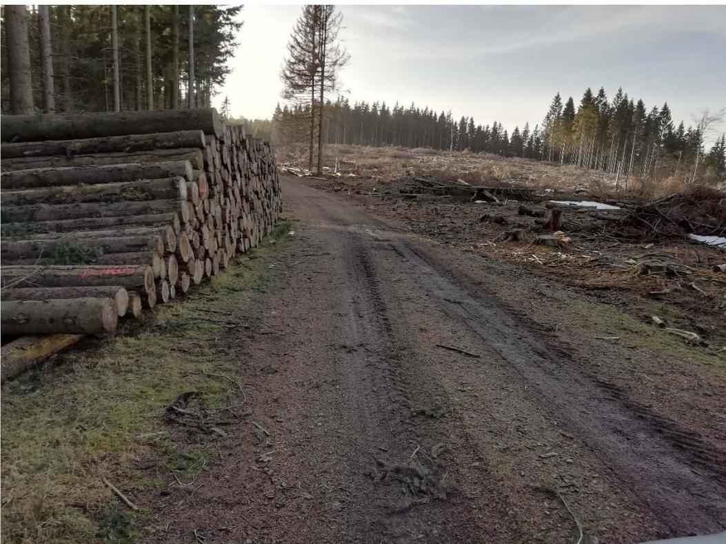
Abbildung 3.31: Zur Vermörtelung vorgesehener Wegabschnitt zwischen WEA 5 und WEA 6
