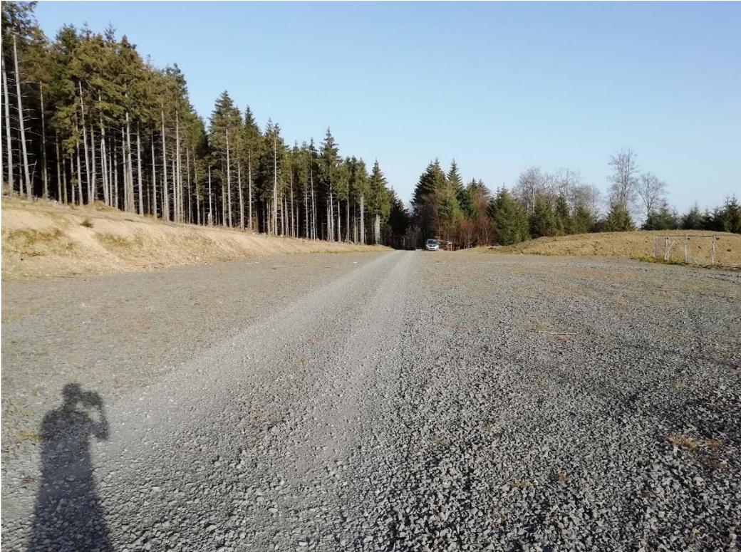
Abbildung 3.30: Zur Lagerung vorgesehene Schotterflächen am ursprünglich geplanten WEA-Standort 5
