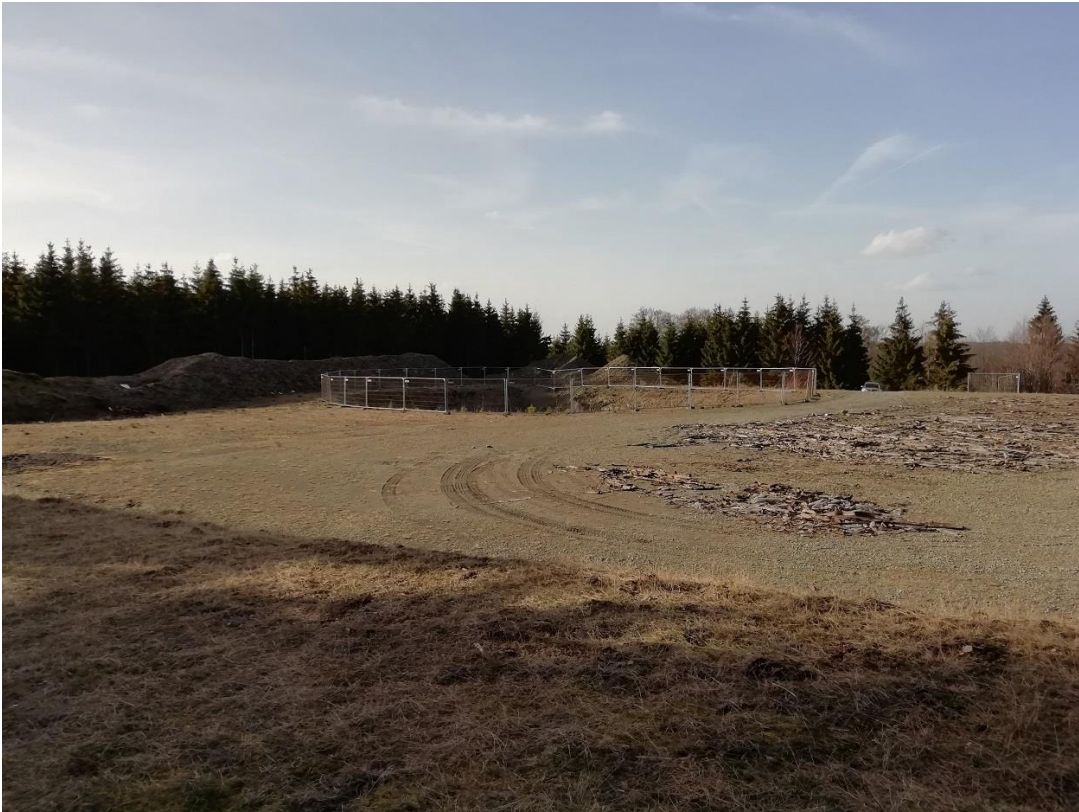
Abbildung 6c: Kahlschlagfläche (AT1, neo1; Nr. 6-5), Kranstellfläche (VF1; Nr. 6-2), Fundamentgrube (VF0; Nr. 6-1) und angrenzende Bodenmieten (GB4; Nr. 6-4) der WEA 6 (Blick in nordwestliche Richtung)
