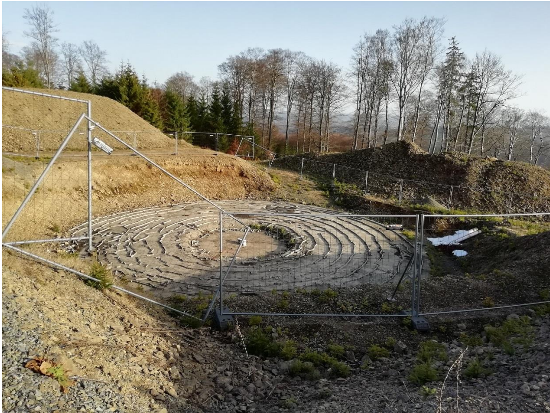
Abbildung 5c: Fundamentgrube (VF0; Nr. 5-1) mit Böschungen (HH0; Nr. 5-5) und angrenzenden Bodenmieten (GB4; Nr. 5-7) der WEA 5 (Blick in südöstliche Richtung)
