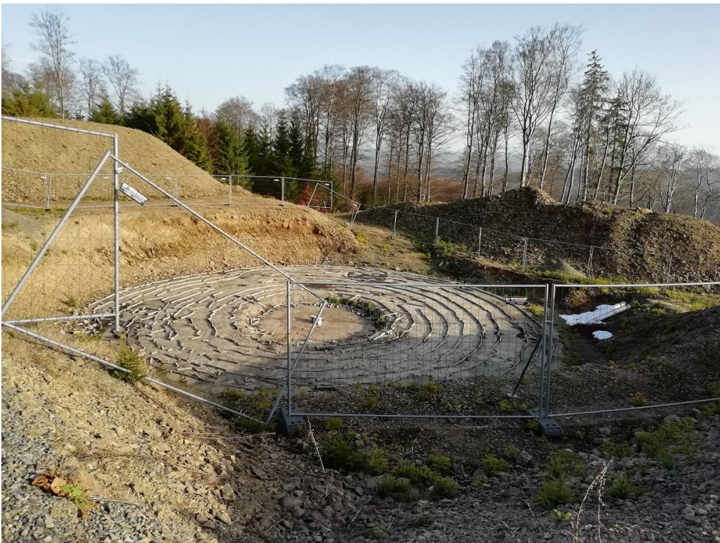
Abbildung 1.1: Im Jahr 2014 hergestellte Fundament-Bodenplatte der geplanten WEA 5
