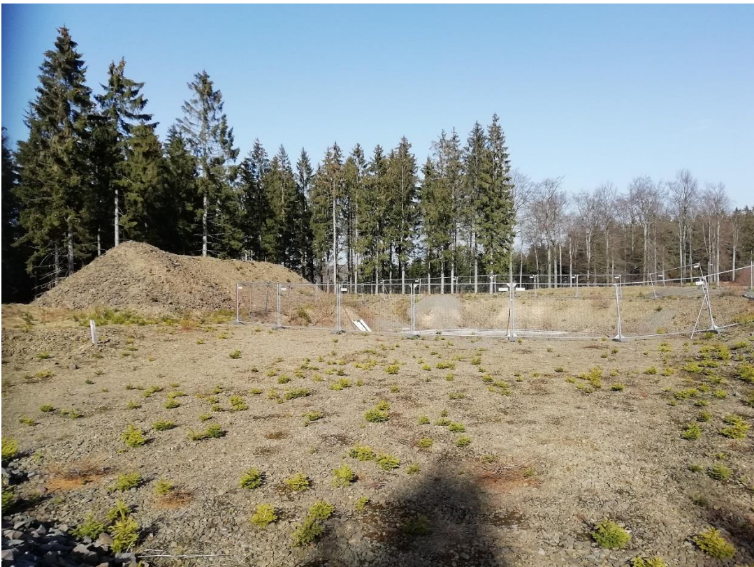
Abbildung 1d: Schotterfläche (VF1 / Kb4; Nr. 1-11), Bodenmiete (GB4; Nr. 1-6) und abgezapfte Fundamentgrube der WEA 1 (VF0, Nr. 1-1) (Blick in nördliche Richtung)
