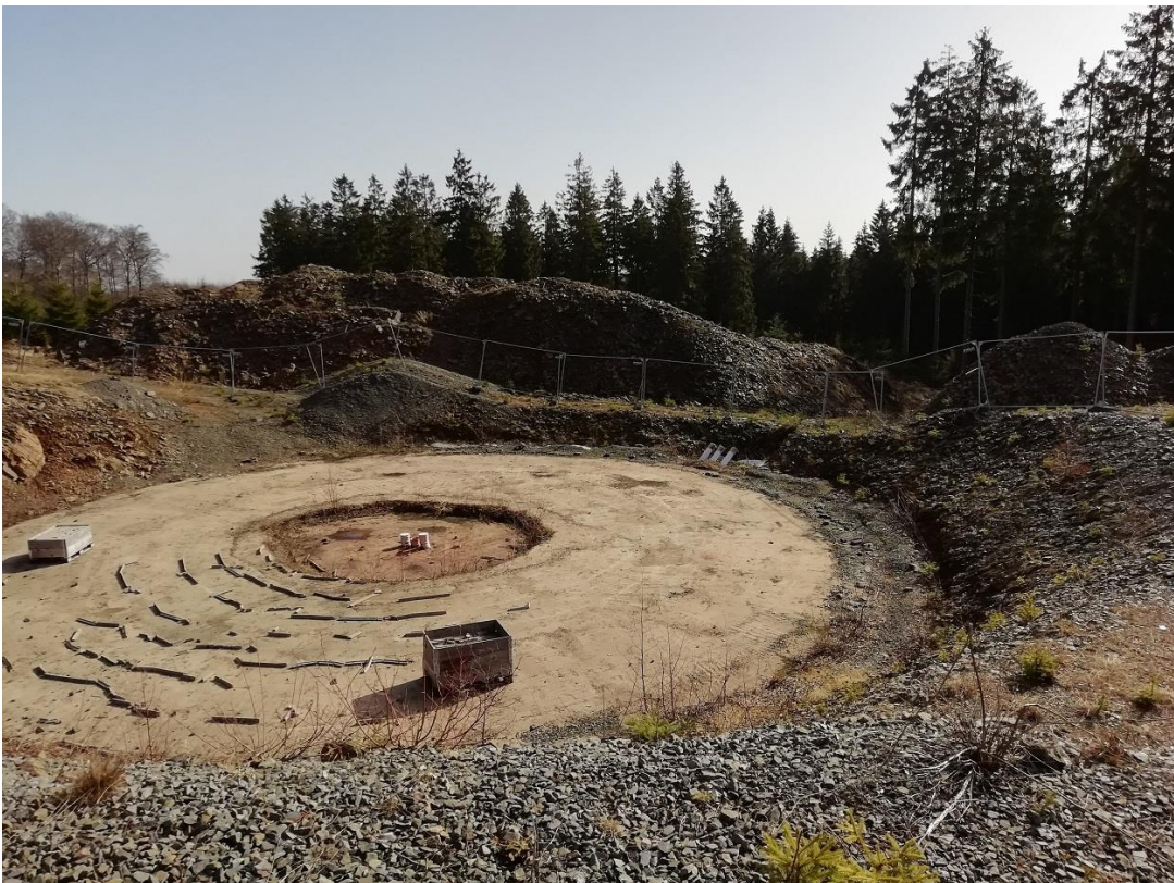
Abbildung 3b: Fundamentgrube (VF0; Nr. 3-1) mit Böschungen (HH0; Nr. 3-4) und angrenzende Bodenmieten (GB4; Nr. 3-6) der WEA 3 (Blick in südöstliche Richtung)
