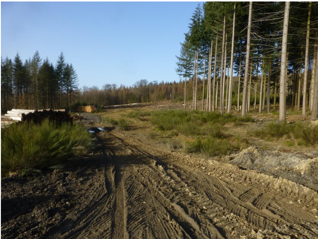
Abbildung 8d: Weg (VF1; Nr. 8-4) und Kranmontagefläche (AT1, neo1; Nr. 8-8) der WEA 8 (Blick in westliche Richtung)
