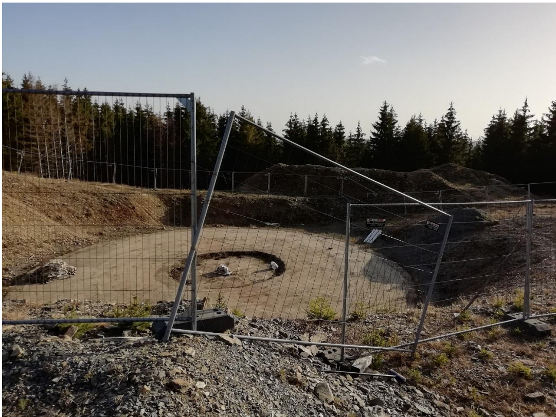
Abbildung 7d: Fundamentgrube (VF0; Nr. 7-1), Böschungen (HH0; Nr. 7-3) und dahinterliegende Bodenmieten (GB4; Nr. 7-4) der WEA 7 (Blick in südliche Richtung)
