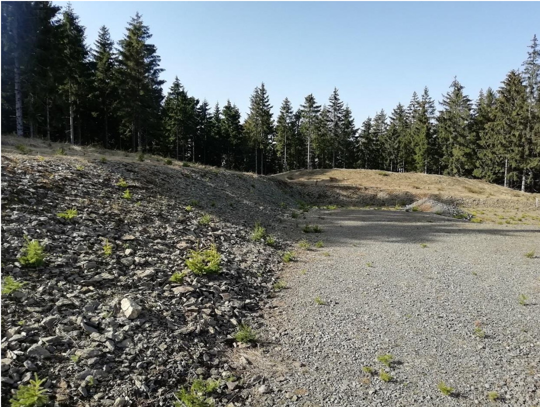
Abbildung 1c: Böschung (HH0; Nr. 1-3) und Kranstellfläche (VF1; Nr. 1-2) der WEA 1 (Blick in westliche Richtung)
