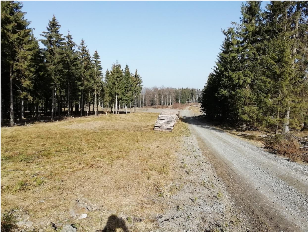
Abbildung 1a: Kranmontagefläche (AT1, neo1; Nr. 1-7) der WEA 1 (Blick in nördliche Richtung)
