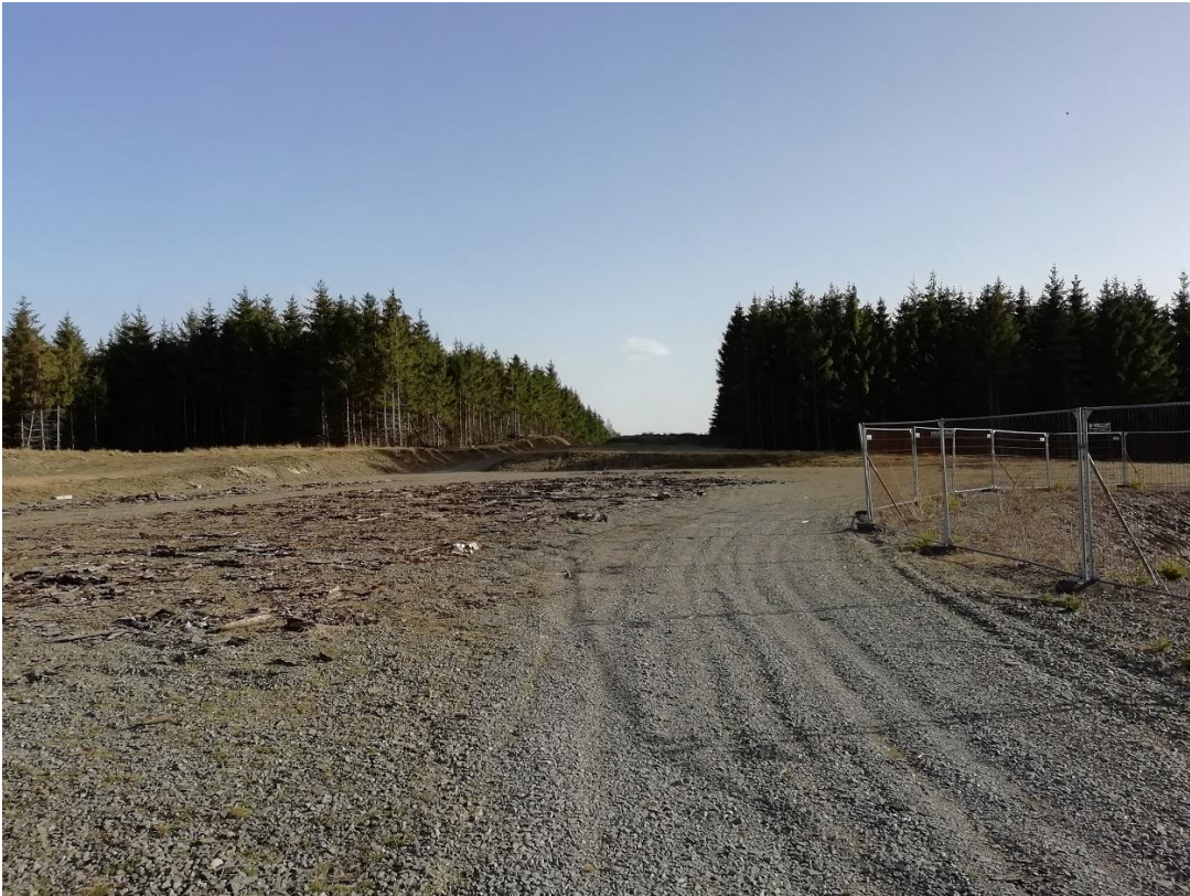
Abbildung 6a: Zufahrt und Kranstellfläche (VF1; Nr. 6-2) der WEA 6 (Blick in südöstliche Richtung)
