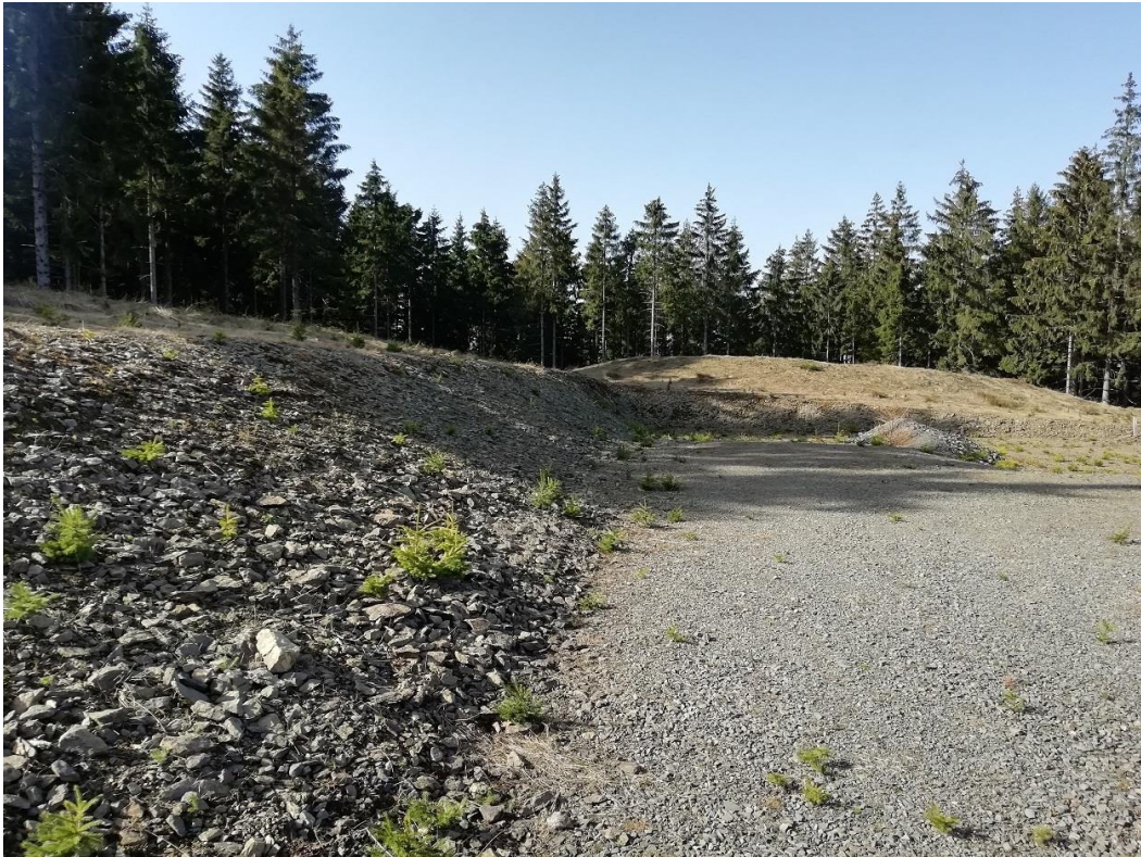
Abbildung 1.2: Im Jahr 2014 hergestellte Schotterflächen, Böschungen und Bodenmieten (im Bildhintergrund) am Standort der geplanten WEA 1
