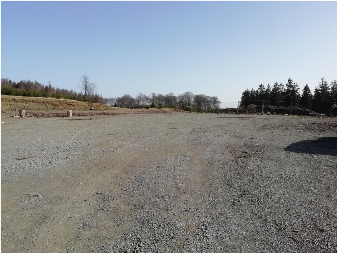
Abbildung 3a: Kranstellfläche (VF1; Nr. 3-2) der WEA 3 (Blick in östliche Richtung)
