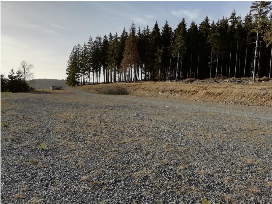
Abbildung 5b: Kranstellfläche (VF1; Nr. 5-2) und angrenzende Böschung (HH0; Nr. 5-4) der WEA 5 (Blick in nordwestliche Richtung)
