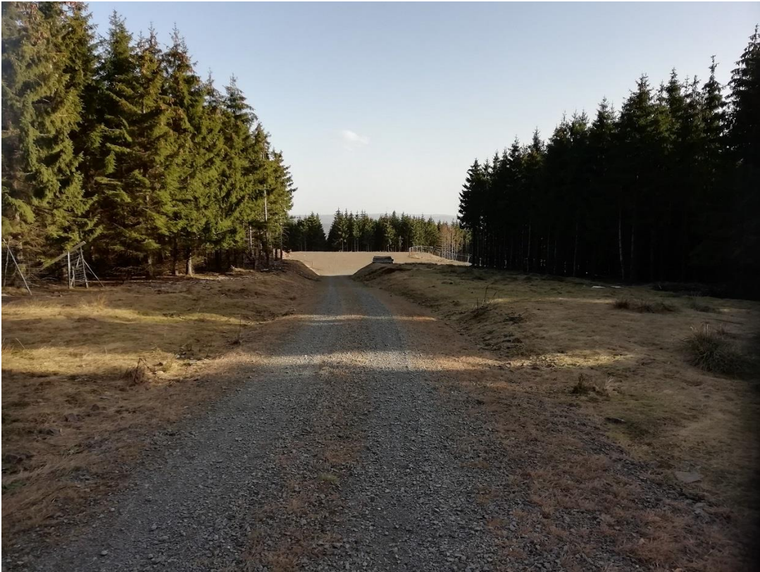
Abbildung 7a: Zufahrt (VF1; Nr. 7-2) und Kahlschlag- bzw. Kranmontageflächen (AT1, neo1; Nr. 7-5) der WEA 7 (Blick in südöstliche Richtung)
