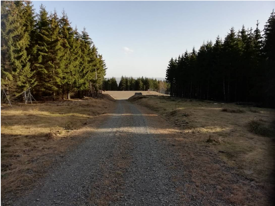
Abbildung 3.14: Im Jahr 2014 hergestellte Zuwegung und Kranmontagefläche der WEA 7
