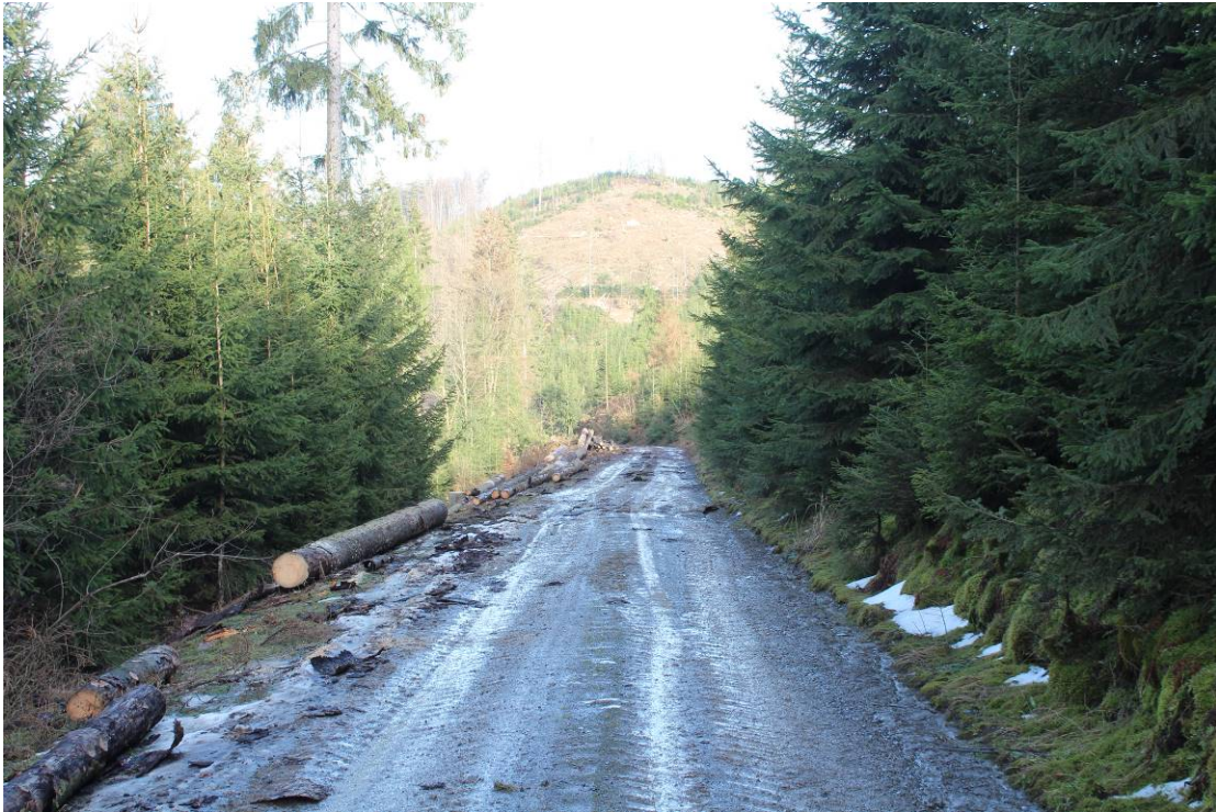
Abbildung 3.22: Wegabschnitt zwischen Gonderbachquerung und „Pariser Platz“; in den jungen Fichtenbeständen auf der südlichen Wegeseite (rechts) ist eine Wegverbreiterung und Verlagerung der Böschung vorgesehen
