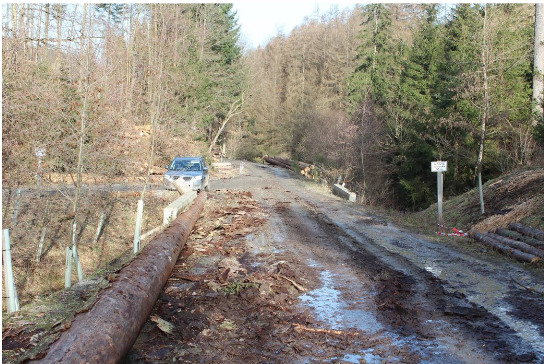
Abbildung 3.21: Im Jahr 2015 neu hergestellte Gonderbachquerung
