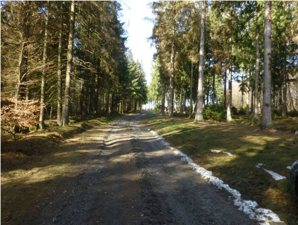
Abbildung 3.26: Zuwegungsabschnitt zwischen WEA 8 und WEA 3
