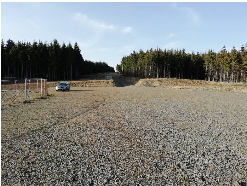
Abbildung 3.15: Im Jahr 2014 hergestellte Bauflächen am geplanten WEA-Standort 7
