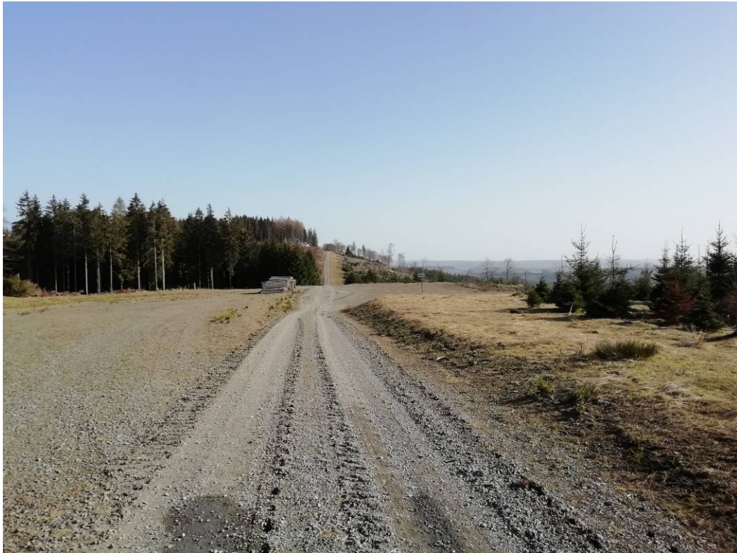
Abbildung 3.30: Zur Baustelleneinrichtung / Lagerung vorgesehene Schotterflächen am ursprünglich geplanten WEA-Standort 4
