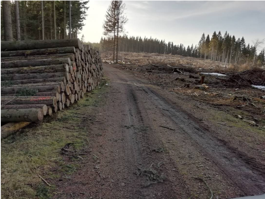
Abbildung 3.32: Zur Vermörtelung vorgesehener Wegabschnitt zwischen WEA 5 und WEA 6
