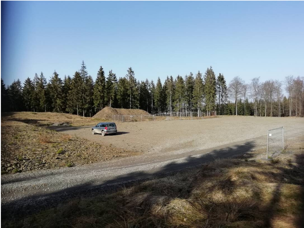
Abbildung 3.3: In den Jahren 2014 /15 hergestellte Bauflächen am Standort der geplanten WEA 1
