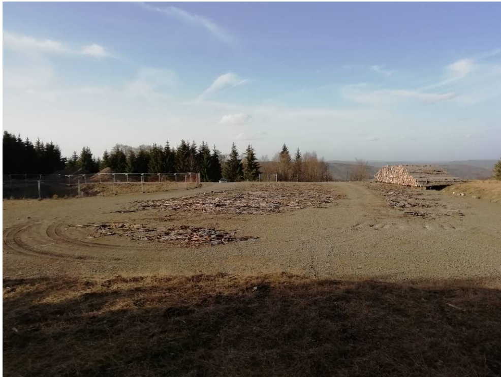
Abbildung 3.12: In den Jahren 2014 /15 hergestellte Bauflächen am Standort der geplanten WEA 6 (Anm.: die gelagerten Baumstämme entstammen Kalamitätshieben durch die Forstwirtschaft in den Jahren 2020 / 21)
