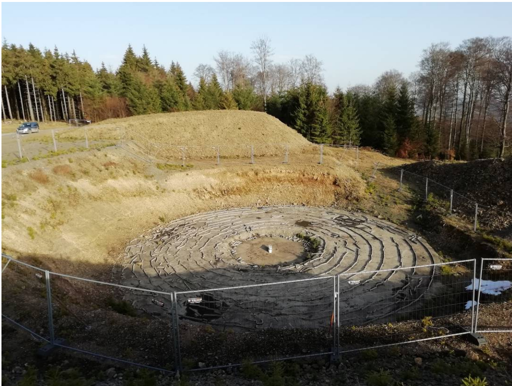
Abbildung 3.9: In den Jahren 2014 /15 hergestellte Bauflächen am Standort der geplanten WEA 5
