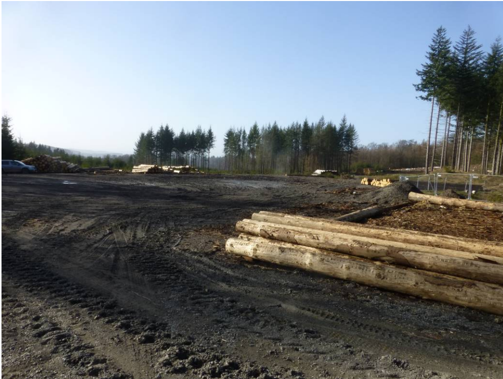
Abbildung 3.17: Im Jahr 2014 hergestellte Bauflächen, die für die geplante WEA 8 genutzt werden (Anm.: die gelagerten Baumstämme entstammen Kalamitätshieben durch die Forstwirtschaft in den Jahren 2020 / 21)
