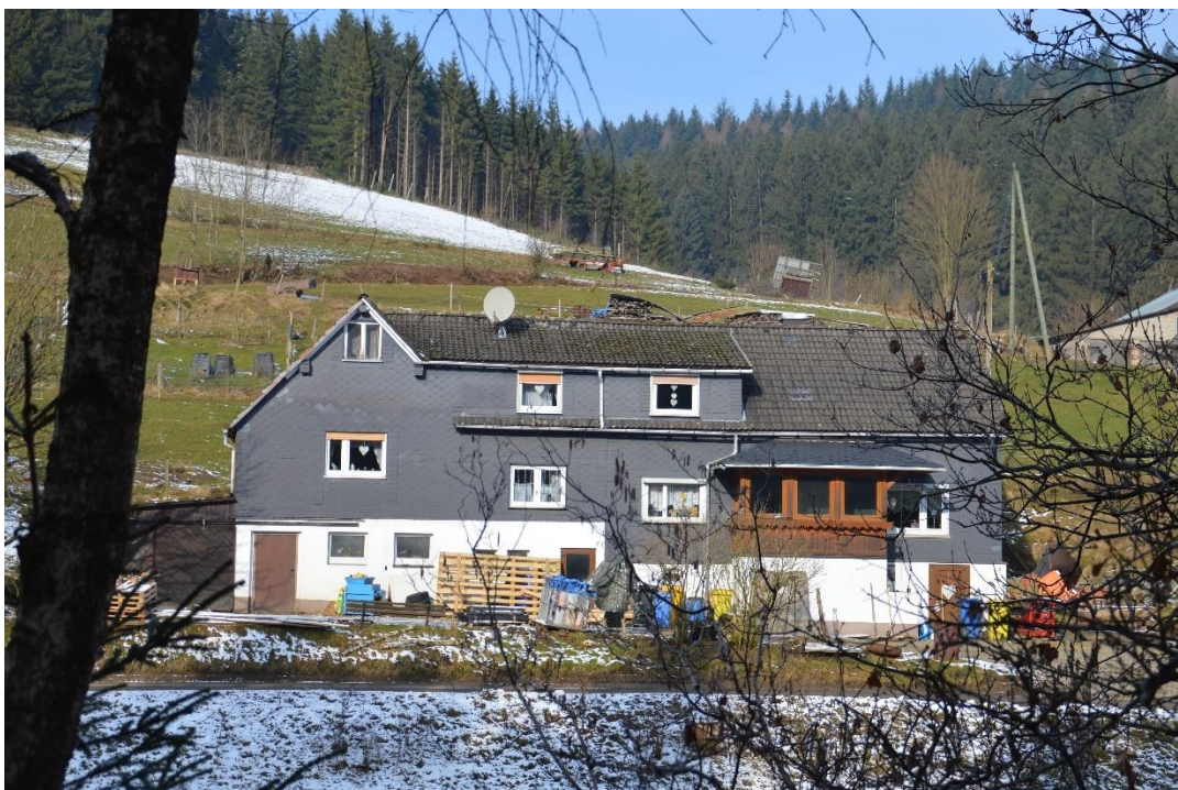
Bild 02: IP 02 Bernshausen, Battenbachweg 6
