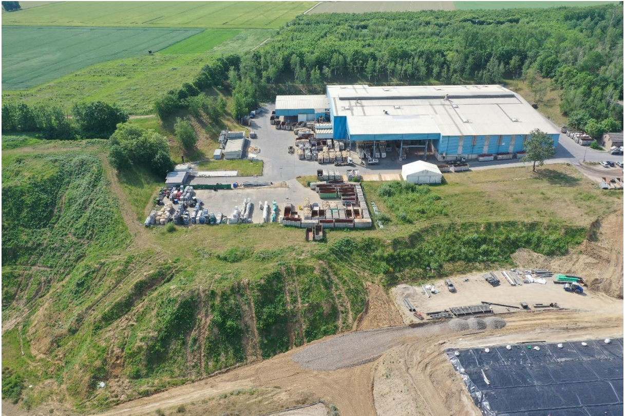
Abbildung 7: Die Wertstoffsortieranlage im südlichen Teil der Deponie.
