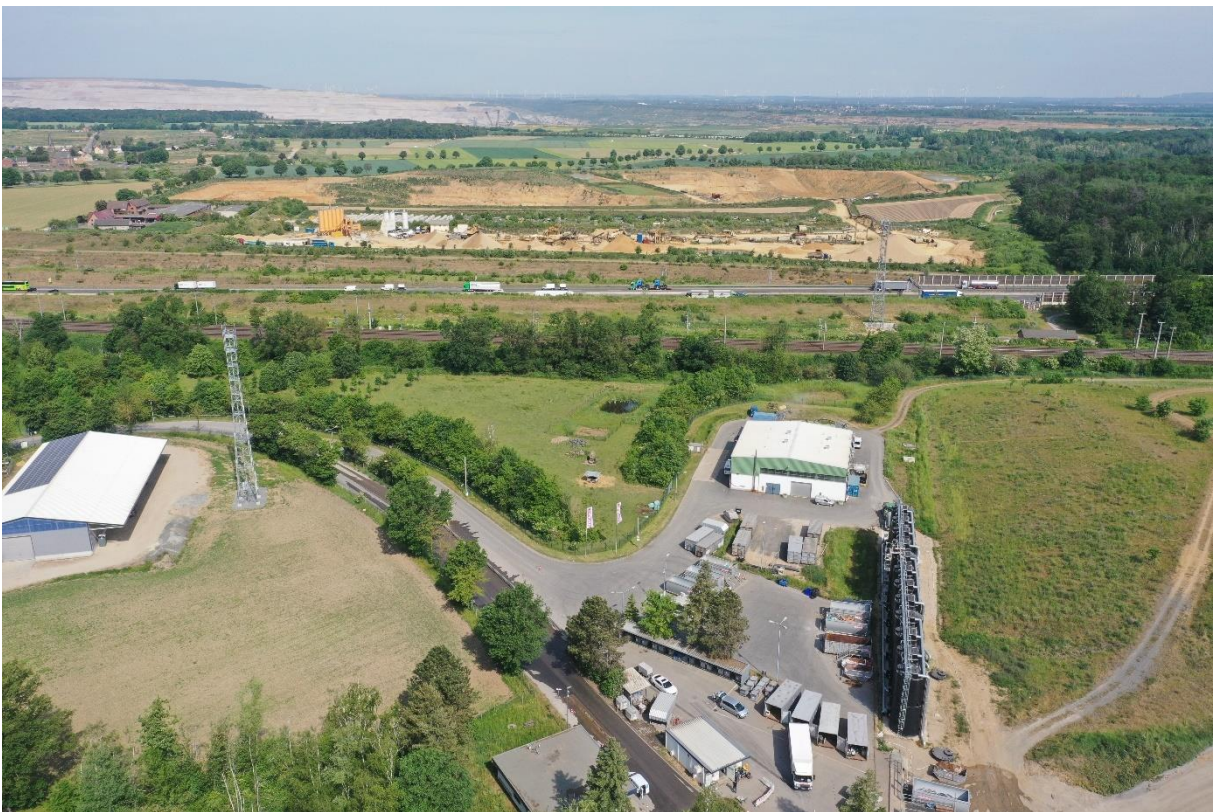
Abbildung 6: Blick nach Norden auf die Amphibienschutzfläche und die Sickerwasseranlage (rechts im Bild).
