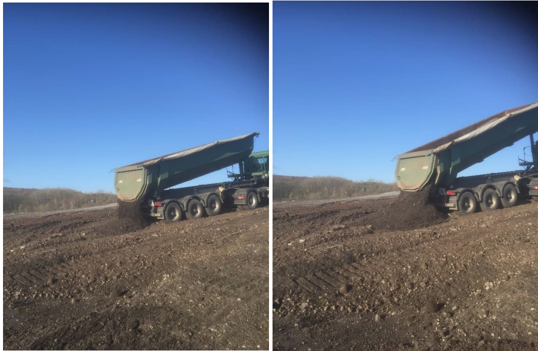
Abbildung 4: Abkippen von Deponat aus einem Sattelaufleger. © ANECO
