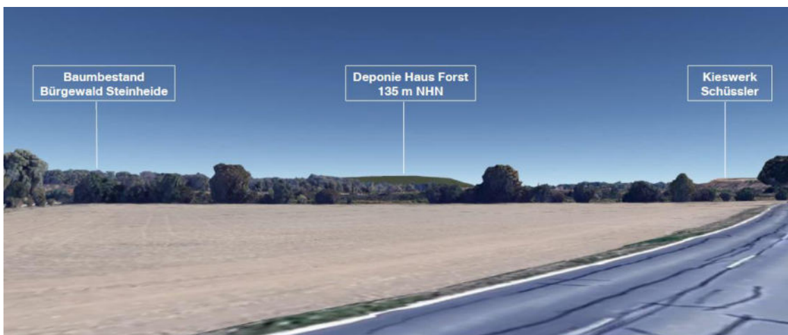
Abb. 23 Visualisierung für den Blickpunkt 2 für die geplante Kubatur (135 m ü. NHN). Quelle: HOCHTIEF 2022
