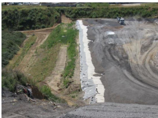
Abb. 14 E' Ausbaugrenze der Basisabdichtung des Deponieabschnittes DA 4b.
