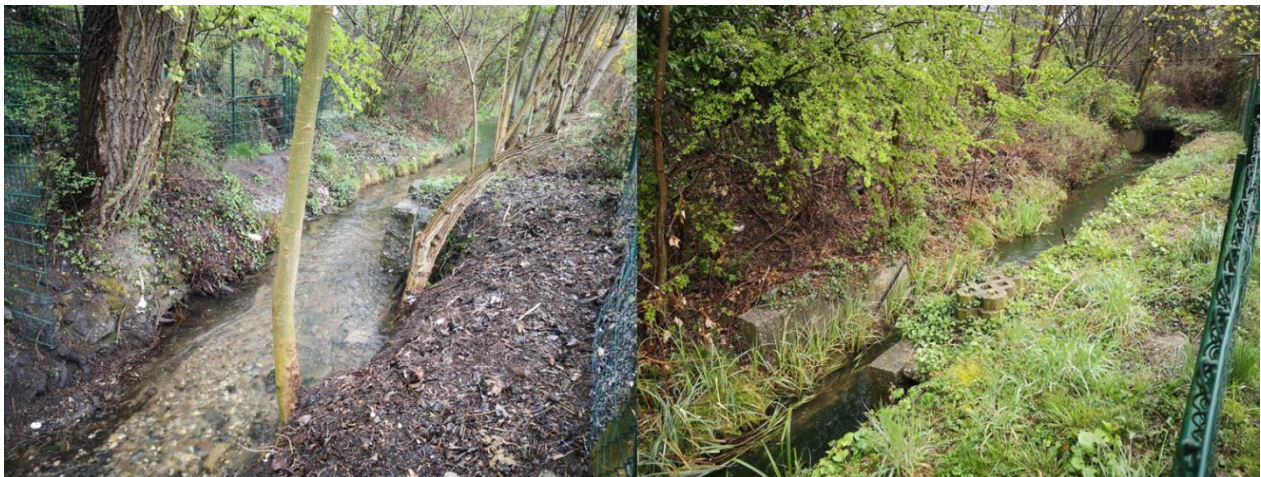
Abb. 2-7: Betonbauwerksfragmente (links, ca. km 2,49) und Mauern zur Rechenmontage (rechts, ca. km 2,45)
