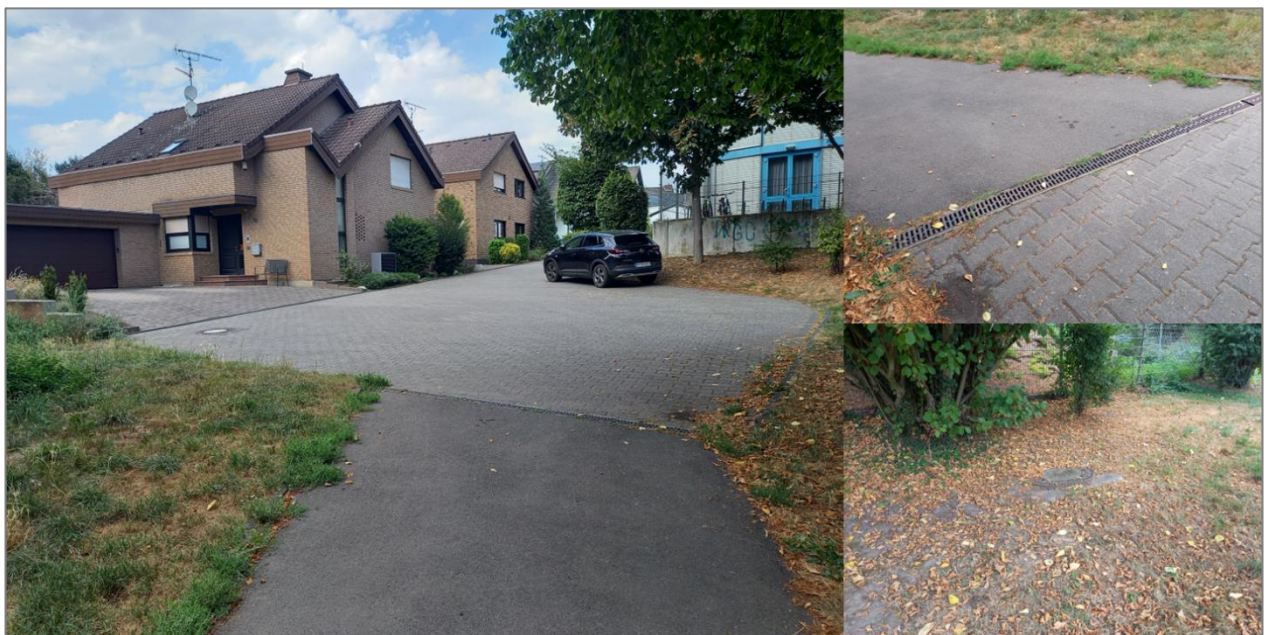
Abb. 2-12: Entwässerungskanäle und Schachtdeckel an der Brigidastraße
