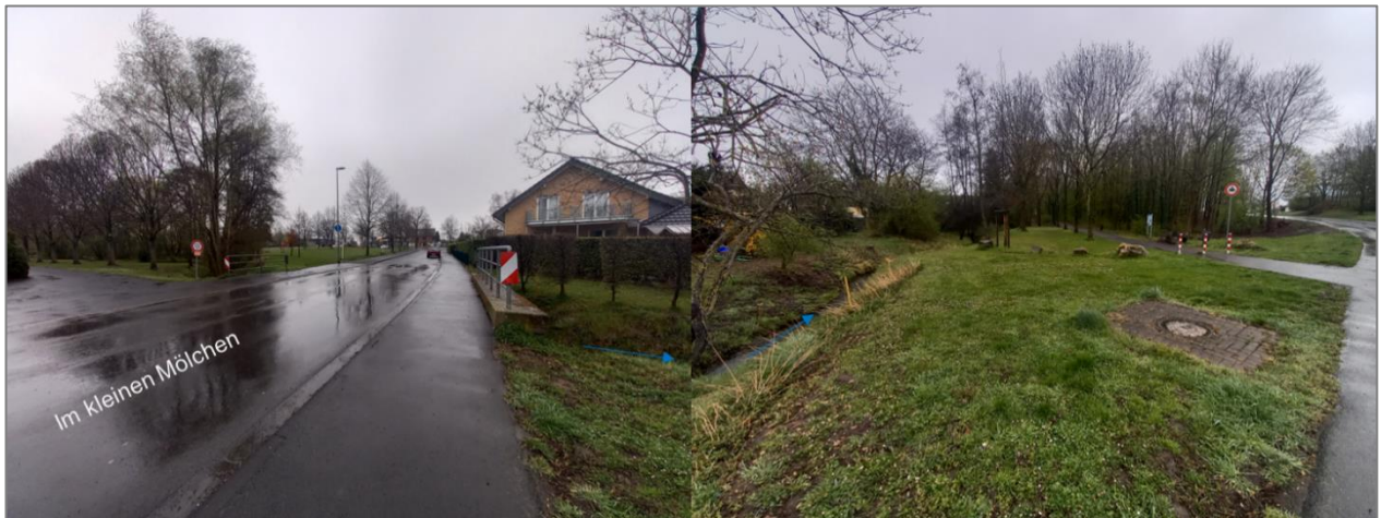
Abb. 2-16: Straße "Im kleinen Mölchen" (links) und paralleler Fuß- und Radweg (rechts)
