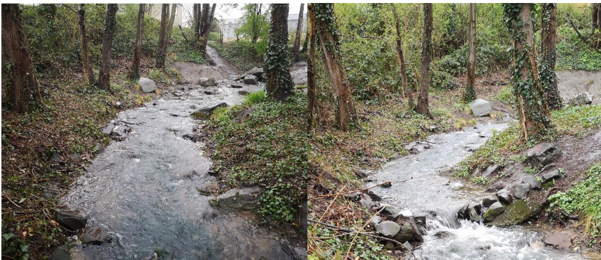
Abb. 3-3: Steilstrecke am Palmersdorfer Bach
