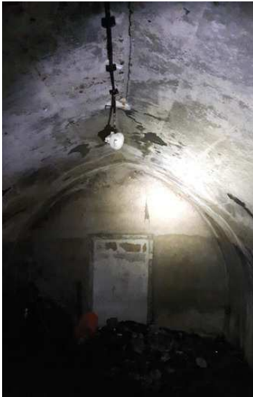
Abbildung 8: Blick ins Innere des zentralen Gewölbes des Splitterschutzbunkers. Das Bauwerk ist ganzjährig frostfrei, bietet jedoch an den glatten Wänden nur wenige Hangmöglichkeiten für Fledermäuse.
