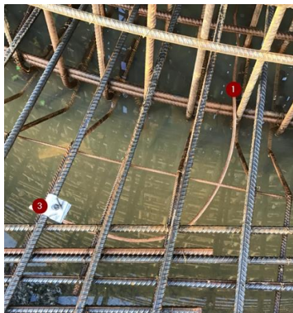
Abbildung 10 Ankerring an Fundamentbewehrung
