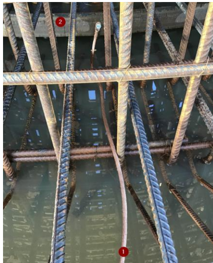
Abbildung 9 Ankerring an Fundamentbewehrung
