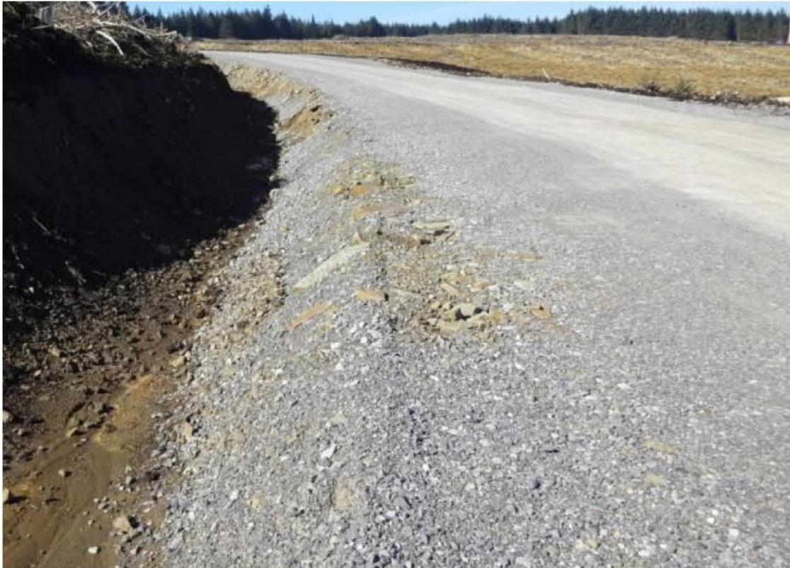
Abbildung 9: *Beispiel für eine gut gepflegte Schotterstraße mit einem Entwässerungsgraben (© Siemens Gamesa Renewable Energy [G 10])*
