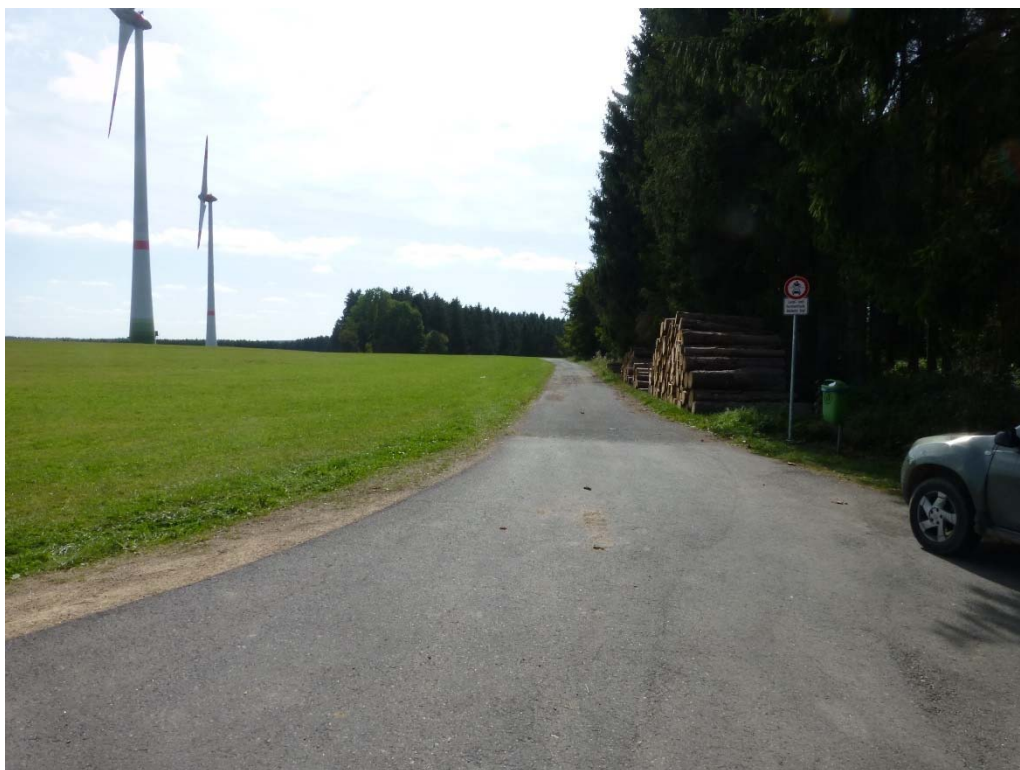
Abbildung 3.10: Östliche Einfahrt von der B 258 zur geplanten Zuwegung zu den WEA 9 und 10
